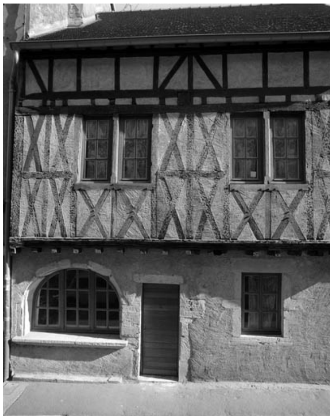
Façade antérieure : détail des pans de bois.
