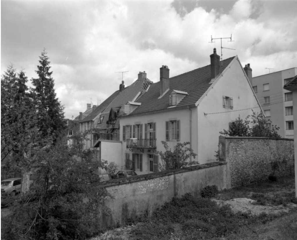
Façade postérieure du bâtiment vue depuis la parcelle voisine.
