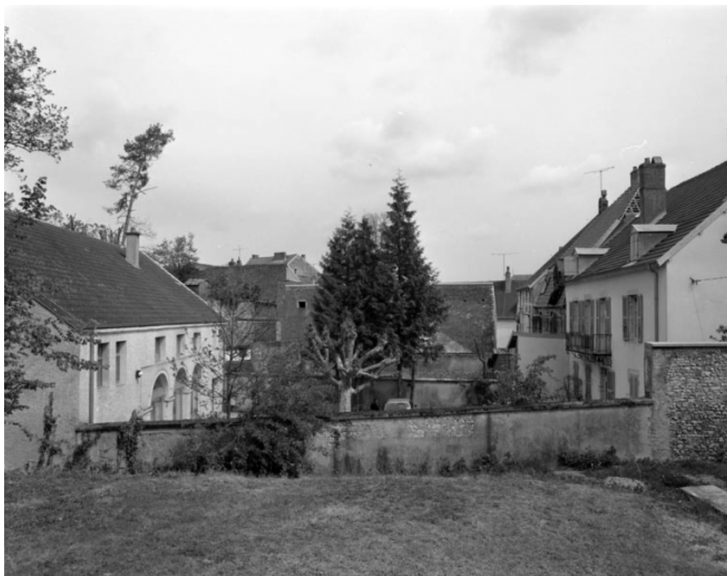
Vue des façades sur cour depuis la parcelle voisine.
