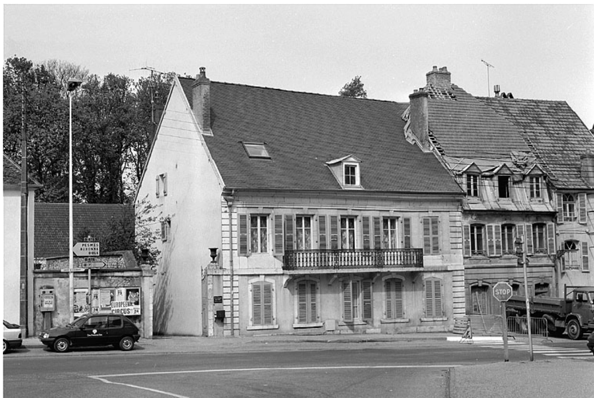
Vue d'ensemble depuis la rue, de trois quarts gauche.
