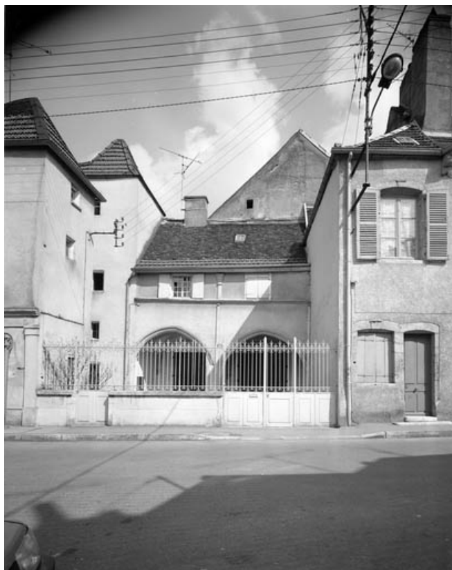
Vue du portique et de la galerie donnant sur la cour.
