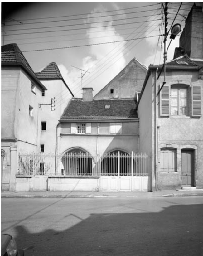
Vue du portique et de la galerie donnant sur la cour. 70, Gray Grande Rue 26
