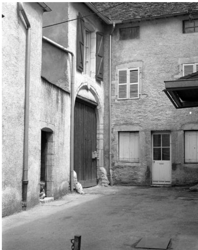
Façade latérale droite : la porte cochère.
