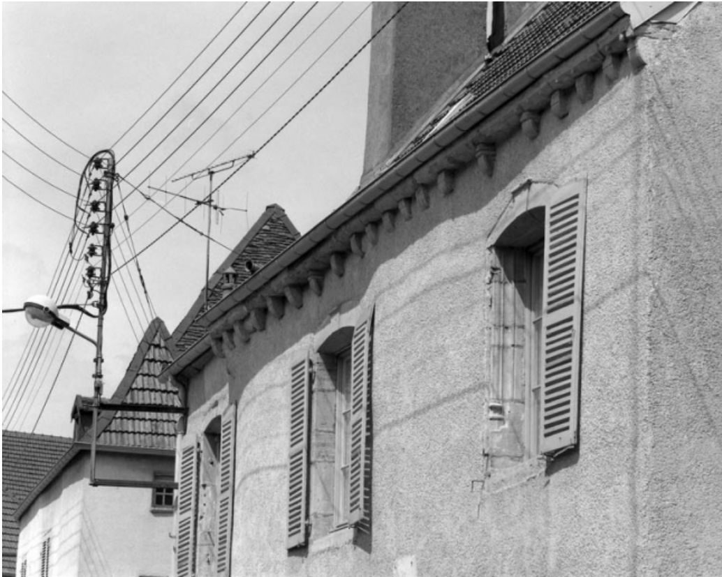
Détail : corniche de la façade antérieure.
