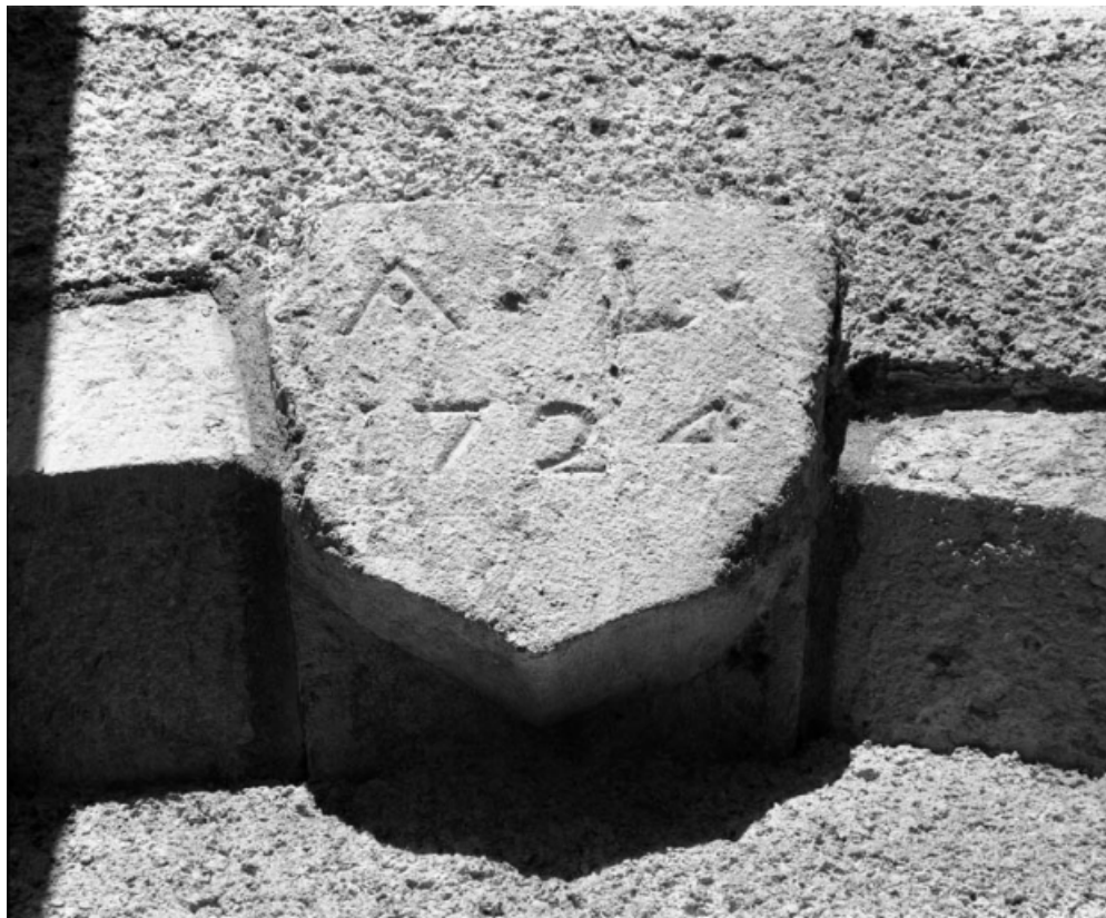
Porte cochère sur façade latérale droite : détail de l'écu portant date et monogramme. 70, Gray Grande Rue 24
