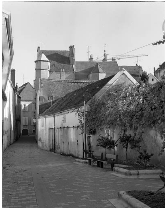
Façade postérieure depuis la rue de l'Abreuvoir. 70, Gray Grande Rue 101
