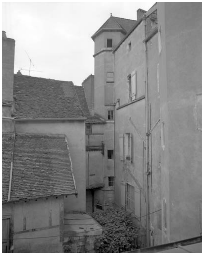
Façade postérieure depuis l'arrière-cour du 99 Grande rue. 70, Gray Grande Rue 101
