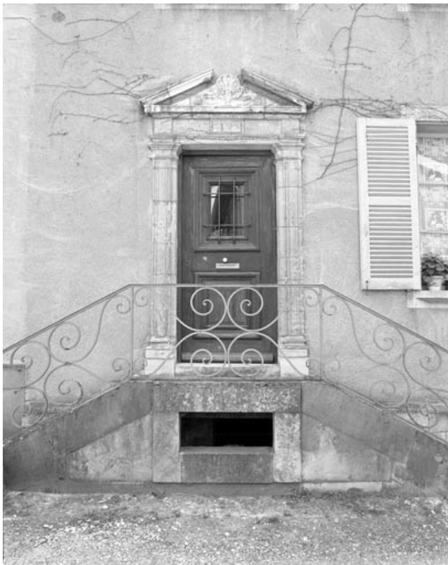
Détail : porte d'habitation sur cour de face.
