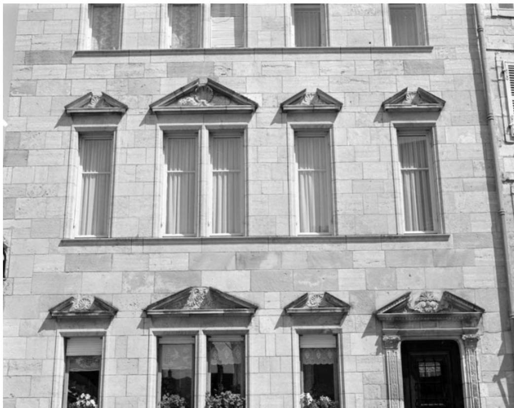
Façade antérieure : décor des baies du rez de chaussée et du premier étage. 70, Gray, 12 rue de l' Eglise
