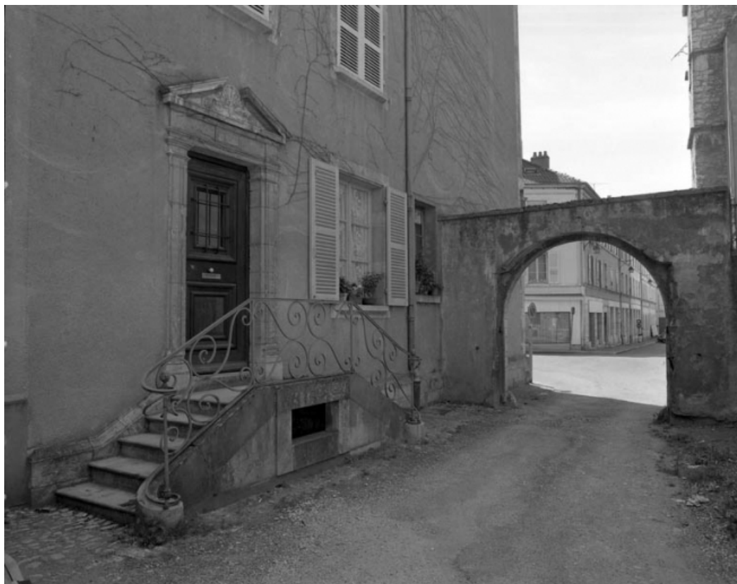
Détail : portail d'entrée de la cour et porte d'habitation sur cour.
