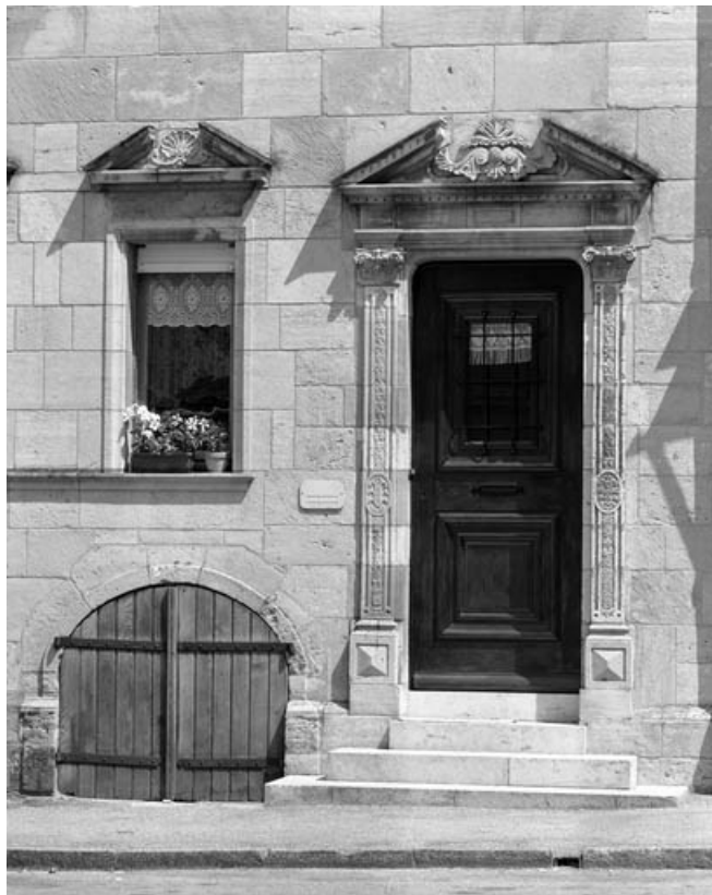
Façade antérieure : détail porte d'entrée sur rue. 70, Gray, 12 rue de l' Eglise
