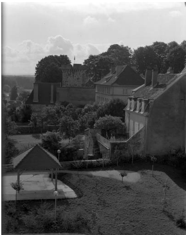
Détail : porte d'habitation sur cour de trois quarts droit.
