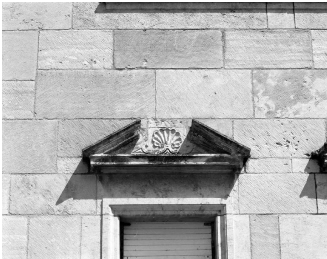
Façade antérieure : détail du fronton d'une baie du rez de chaussée. 70, Gray, 12 rue de l' Eglise
