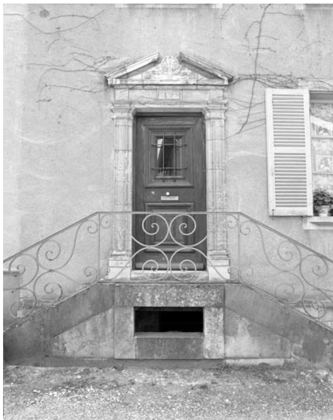
Détail : porte d'habitation sur cour de face.
