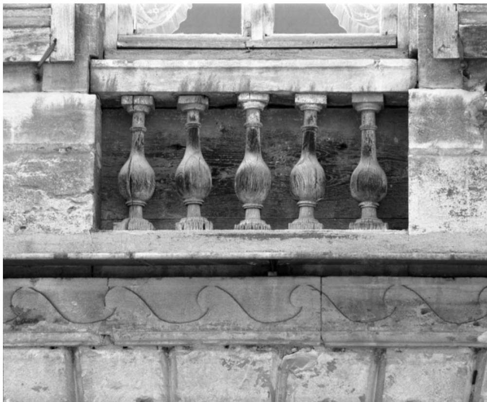
Façade antérieure : détail d'un garde-corps.
