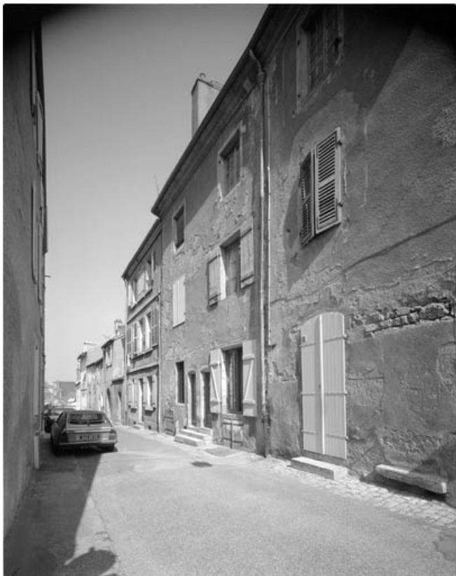
Façade latérale gauche. 70, Gray, 18 place De Gaulle
