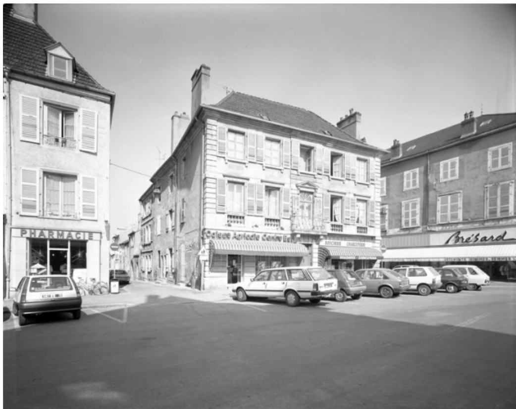
Façade antérieure et latérale gauche.
