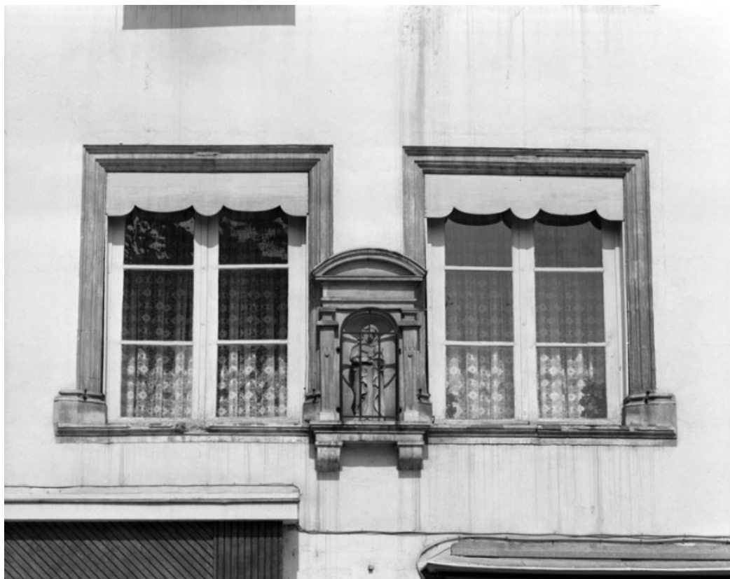
Façade antérieure : détail du premier étage.
