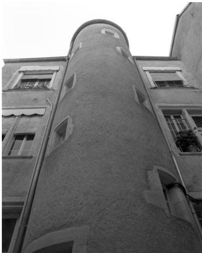
Vue de la tour d'escalier sur la façade postérieure de la partie droite de l'édifice. 70, Gray, 13, 14 place De Gaulle
