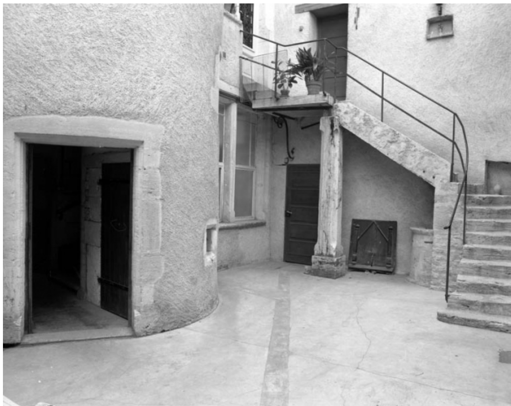
Vue de l'escalier extérieur en équerre sur façade postérieure de la partie droite de l'édifice. 70, Gray, 13, 14 place De Gaulle
