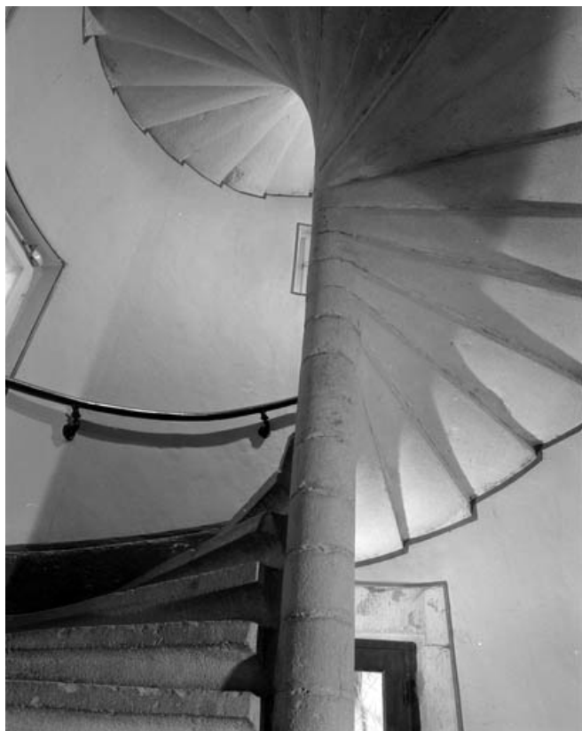
Détail de l'escalier en vis, partie droite de l'édifice.
