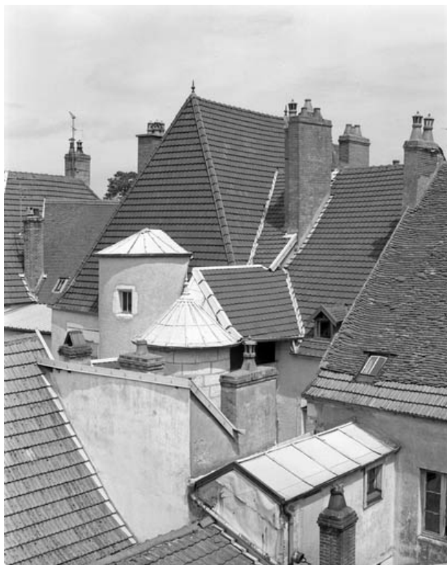
Façade postérieure : vue des toitures.
