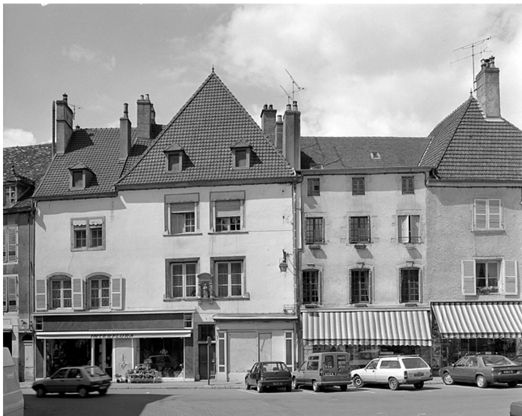
Vue d'ensemble façade antérieure, de face.
