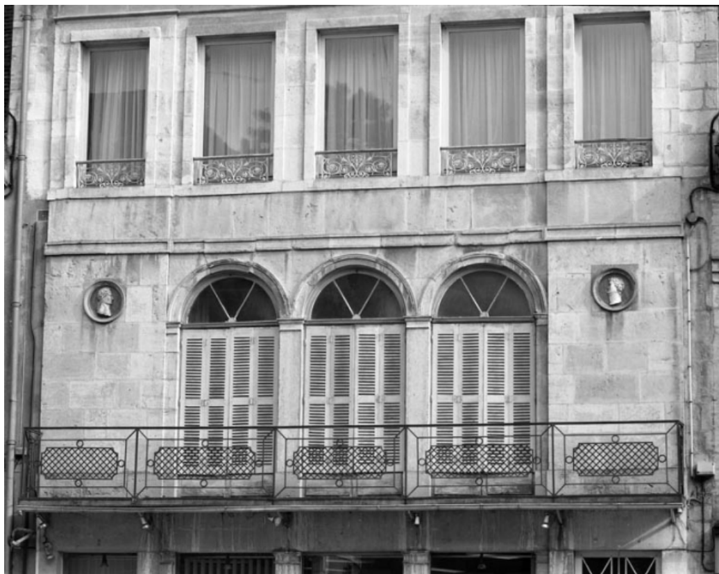
Façade antérieure : détail des baies du premier étage.
