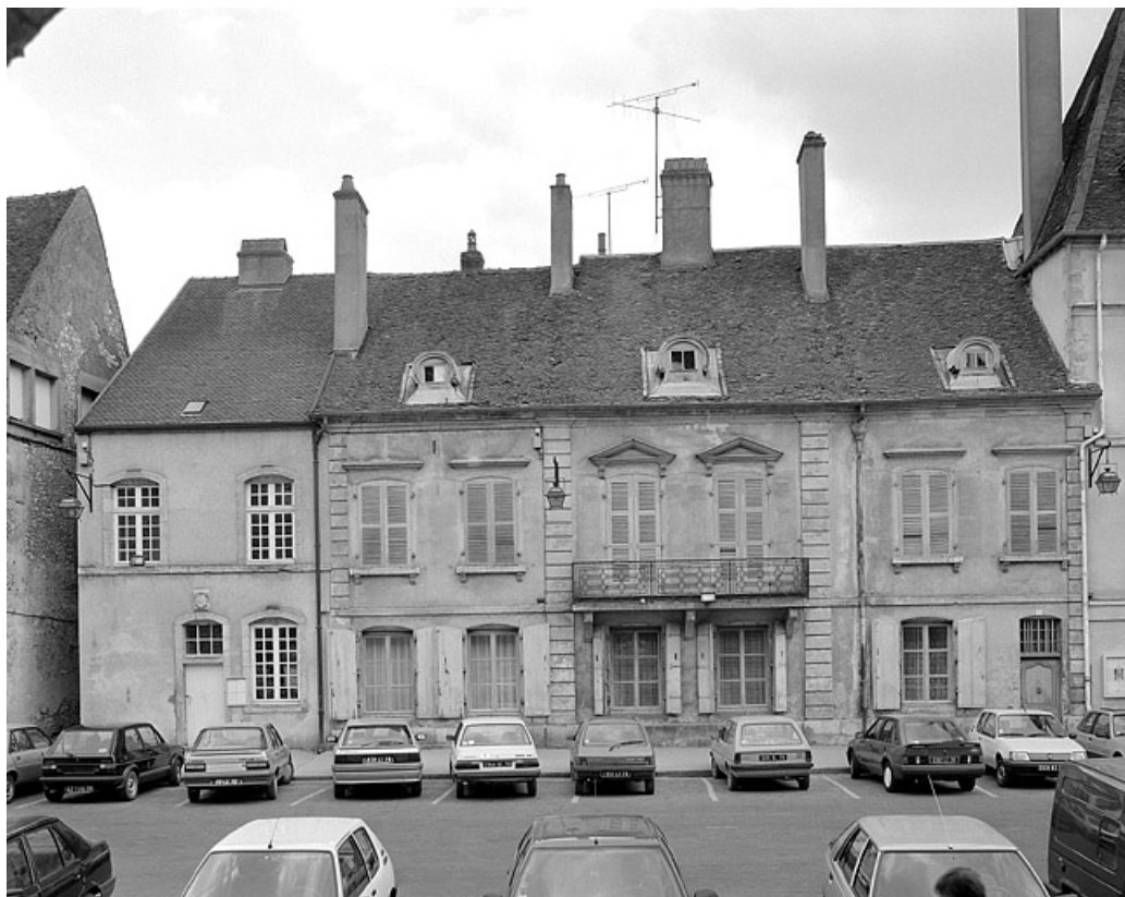
Façade antérieure de l'édifice principal, de face. 70, Gray, 6 place De Gaulle
