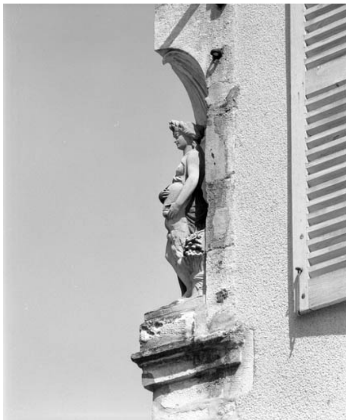
Détail de la niche et de la statuette à l'angle de la façade principale : de profil. 70, Gray, 4 place De Gaulle
