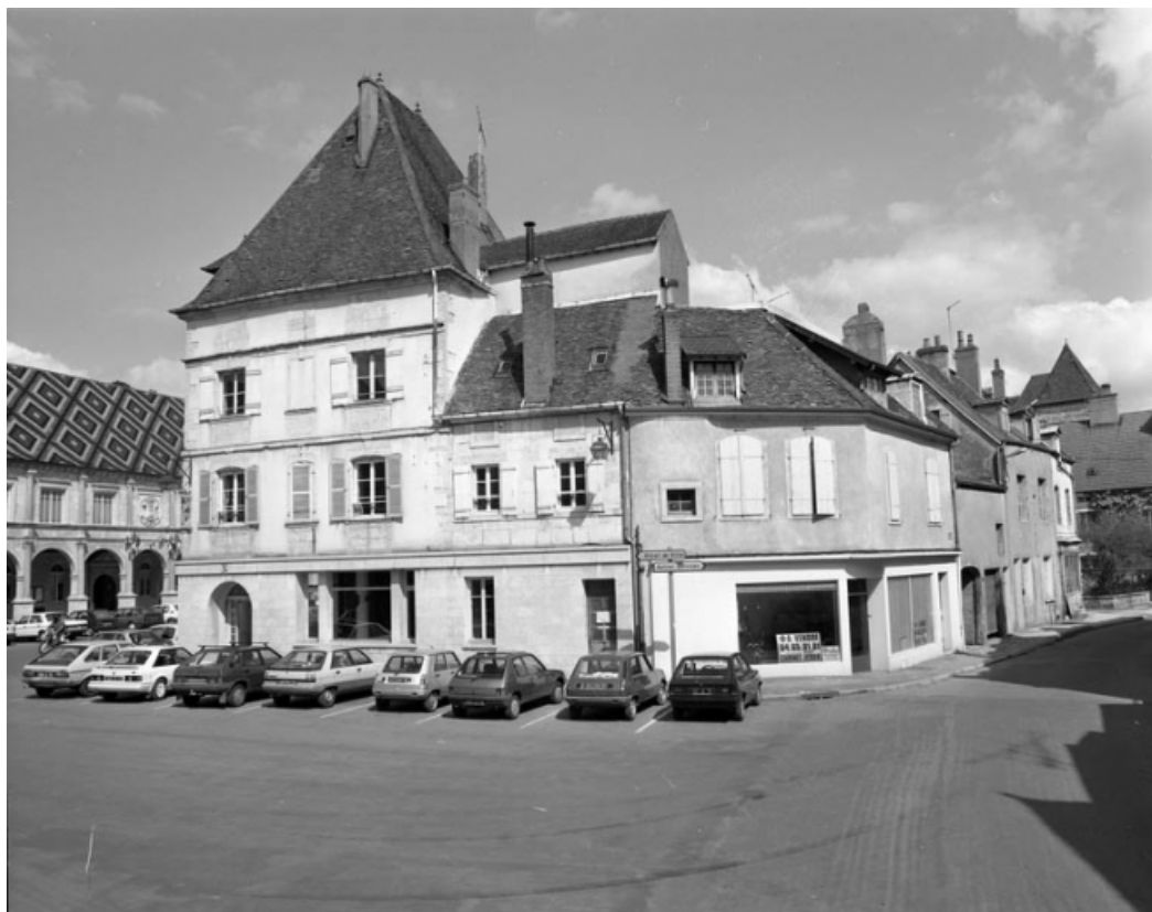
Façade latérale droite.
