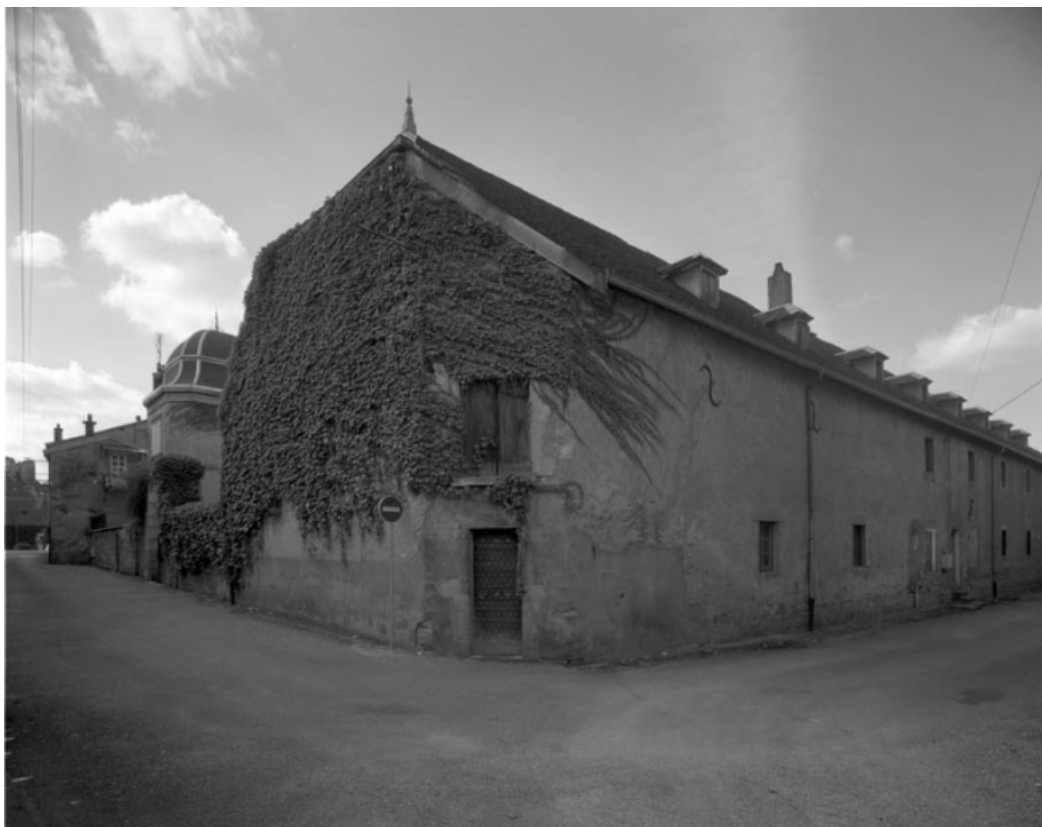
Façades postérieure et latérale droite de l'entrepôt.
