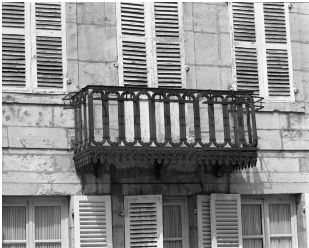
Façade antérieure : détail du balcon en ferronnerie.
