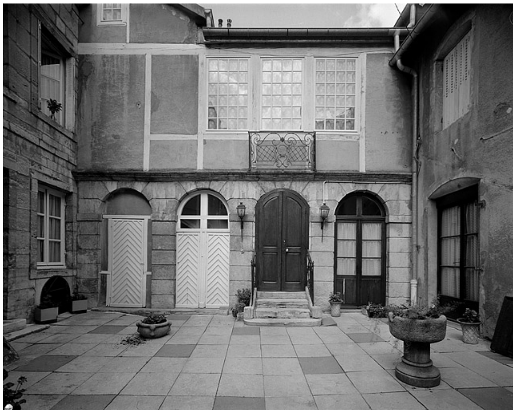
Bâtiment de liaison de face, entre habitation sur rue et habitation sur cour. 70, Gray, 8 rue de la Charité
