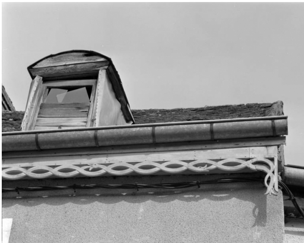
Détail de la frise en bois sous la rive du toit de la façade antérieure.
