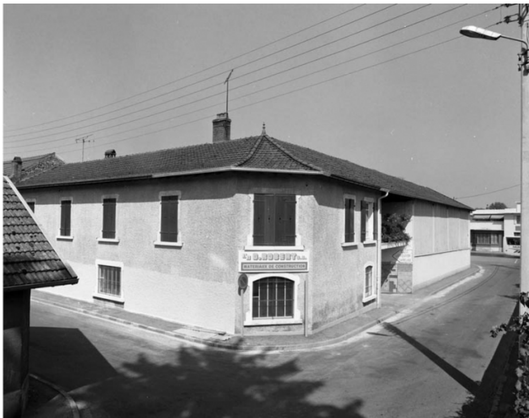
Façades postérieure et latérale gauche à l'angle des rues de la Gare et de Belfort. 70, Gray, 30 avenue Carnot
