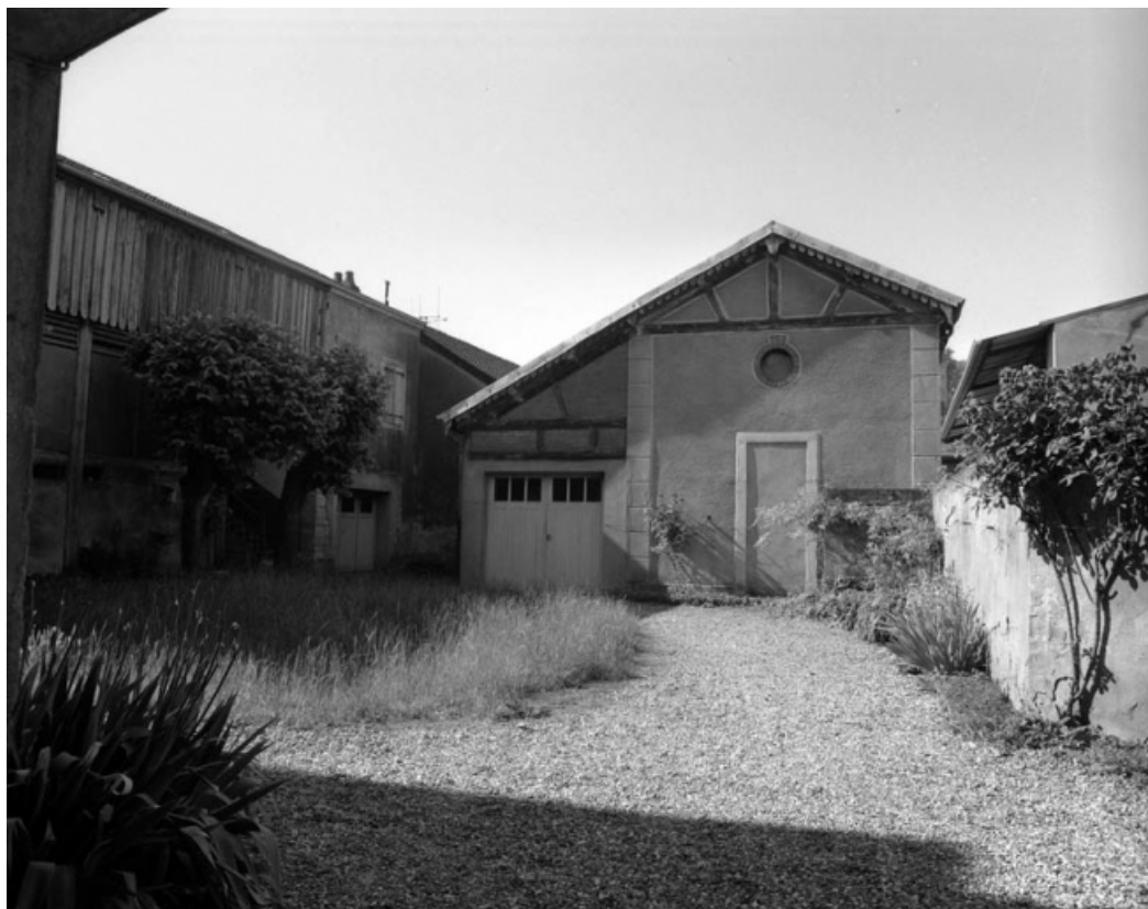
Bâtiment dans la cour à fonction non définie.
