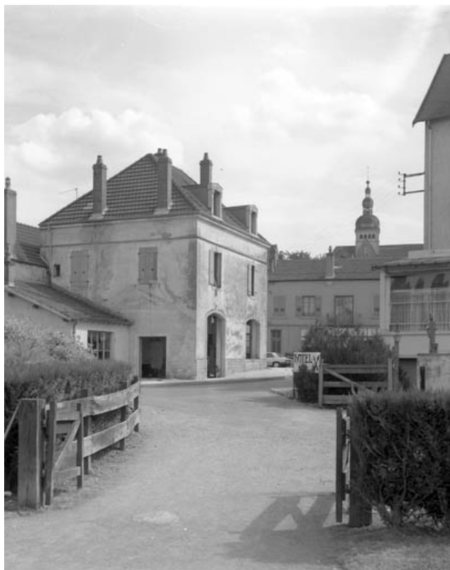
Façades postérieure et latérale gauche.
