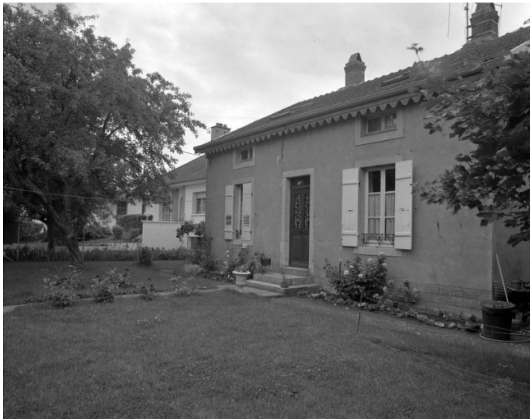
Façade antérieure de trois quarts droit, depuis la cour.
