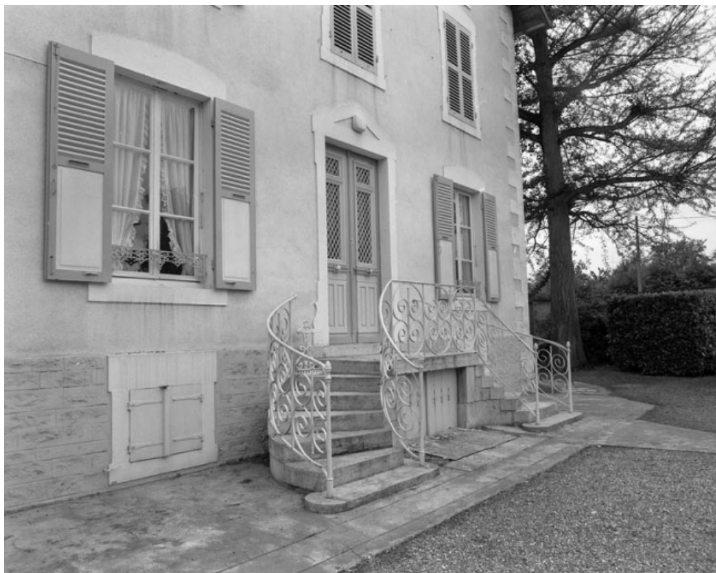
Détail du perron de l'habitation.
