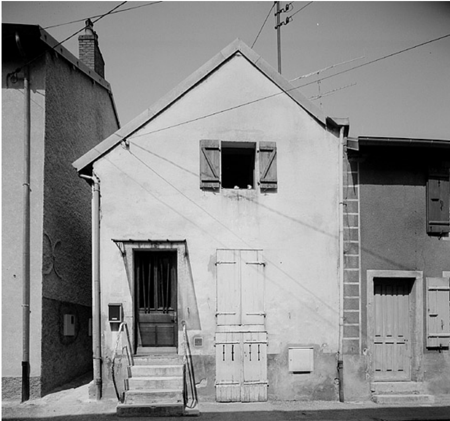
Façade antérieure de face.
