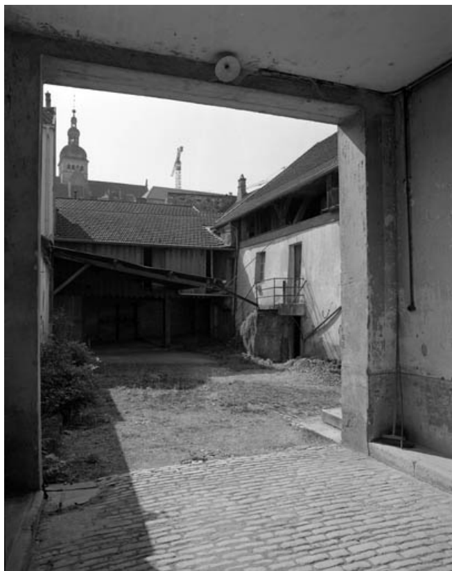
Hangar en fond de cour et logement avec séchoir à droite.
