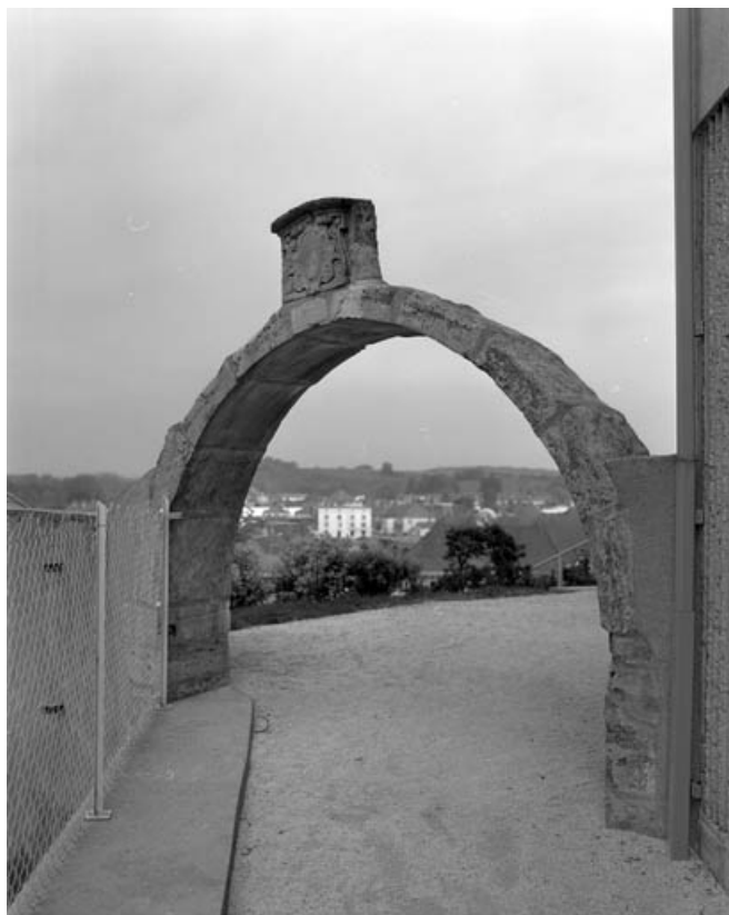
Reste de l'ancien presbytère de la rue de la Malcouverte détruit par un obus en 1940. 70, Gray rue Pigalle
