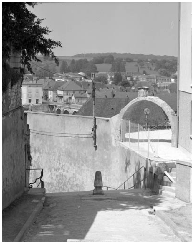
Restes de l'ancien presbytère de la rue de la Malcouverte détruit par un obus en 1940. 70, Gray rue Pigalle
