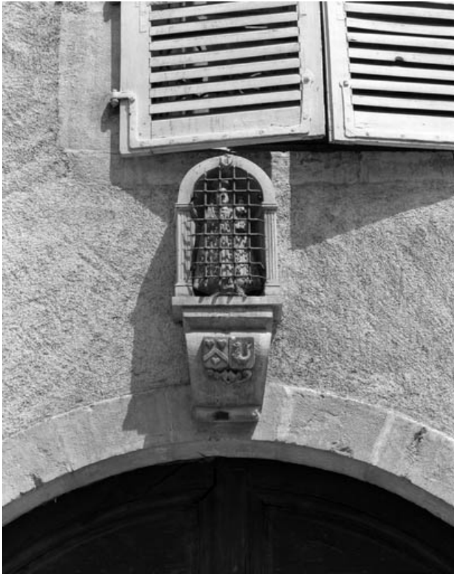
Façade antérieure : portail d'entrée, détail de la clef de l'arc. 70, Gray, 13 rue Victor Hugo
