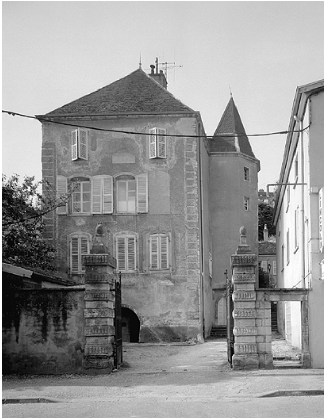
Vue d'ensemble depuis la rue.
