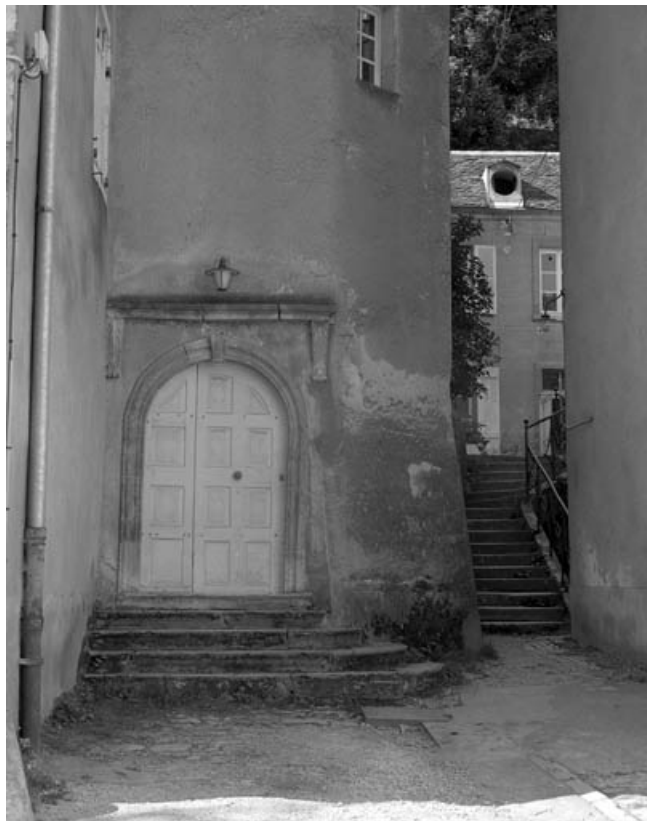
Détail : porte de l'escalier demi hors-oeuvre donnant sur la première cour. 70, Gray, 30 rue Vanoise
