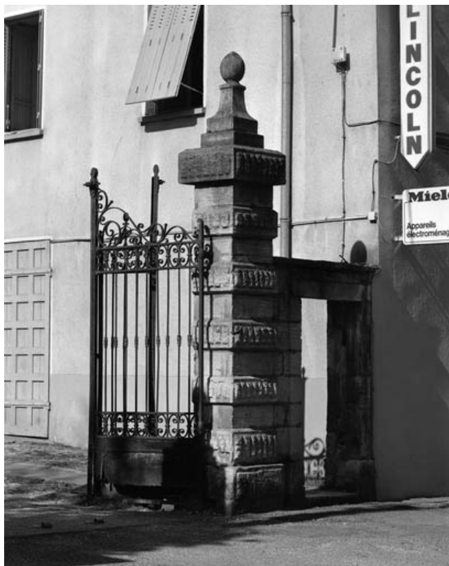
Détail de la partie droite du portail d'entrée de la première cour. 70, Gray, 30 rue Vanoise
