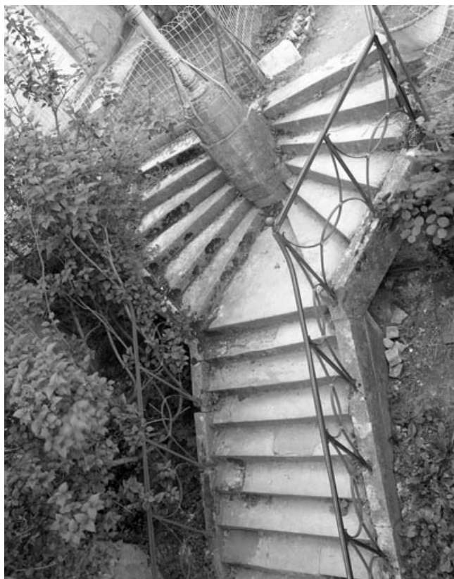
Détail de l'escalier isolé desservant la deuxième cour. 70, Gray, 30 rue Vanoise
