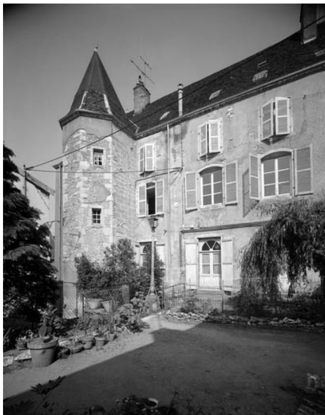
Façade antérieure de l'hôtel : détail de la partie gauche.
