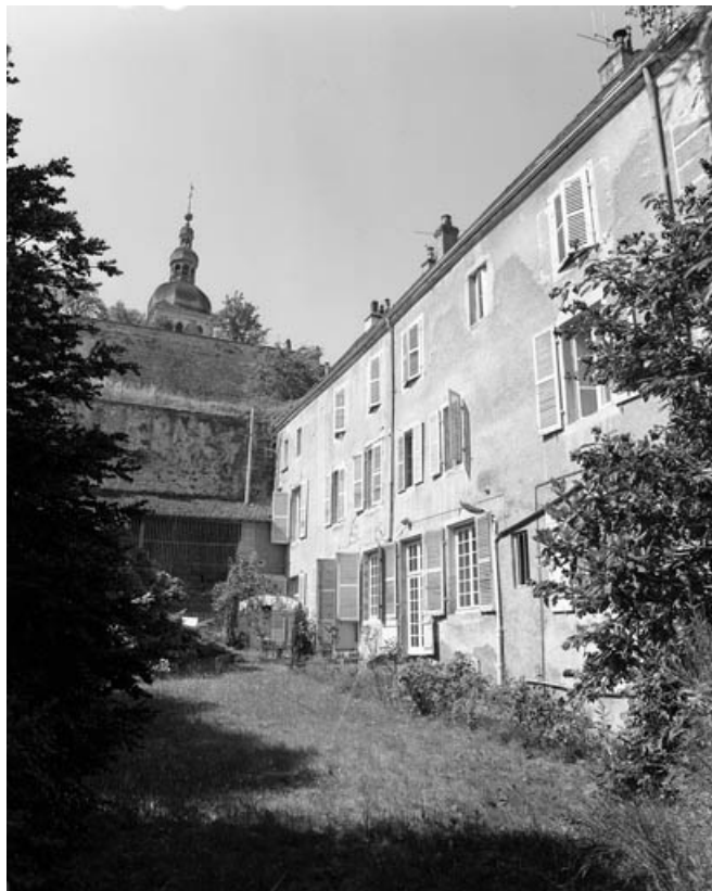
Façade postérieure de l'hôtel.
