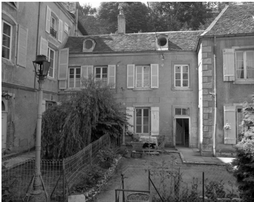
Logement annexe gauche : façade antérieure de face.
