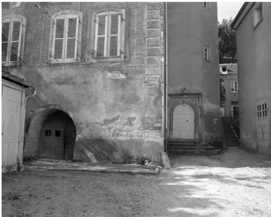
Détail du rez de chaussée sur la première cour.
