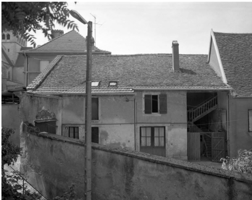
Façade antérieure du logement sur cour.
