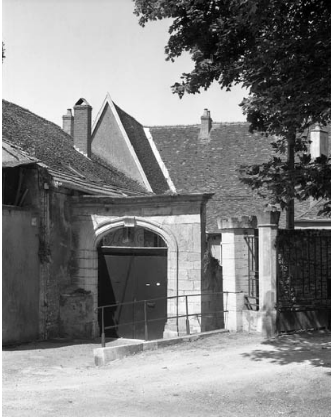
Le portail d'entrée de la cour.
