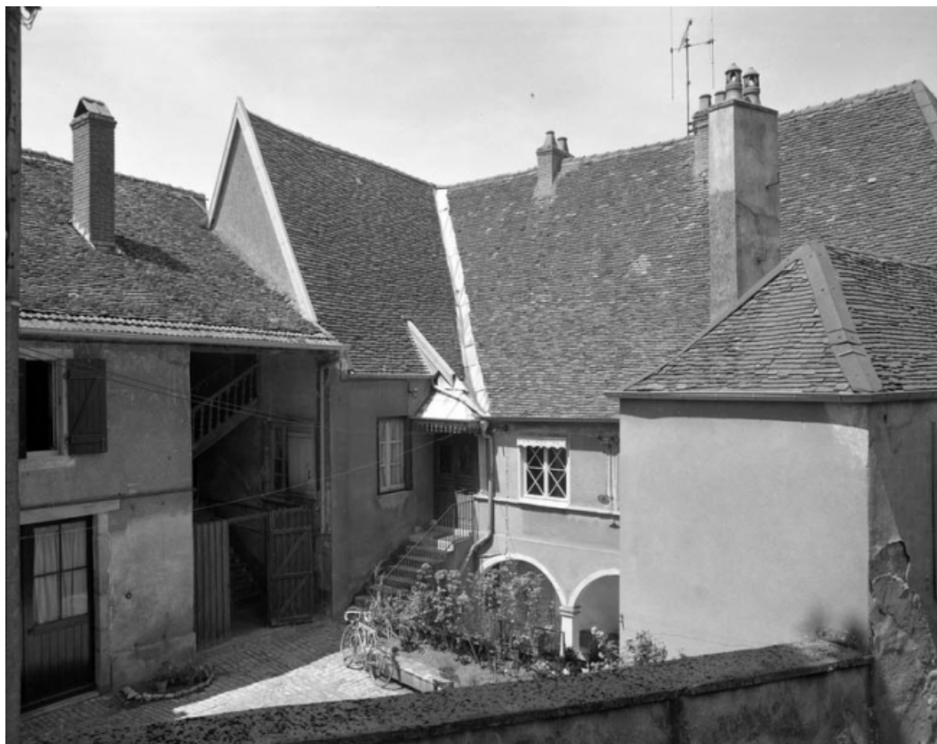
Façade antérieure de trois quarts droit depuis l'esplanade du château.
