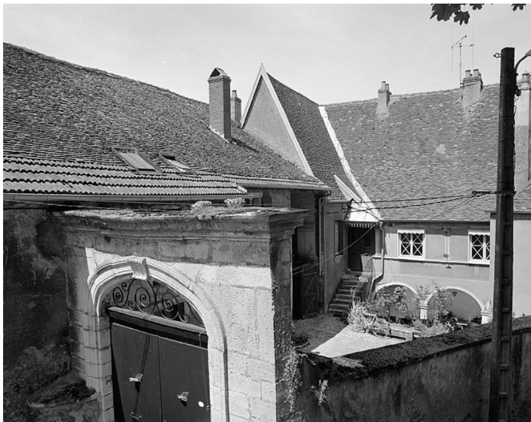
Vue de la façade sur cour et du portail d'entrée depuis l'esplanade du château. 70, Gray rue du Terre du Château
