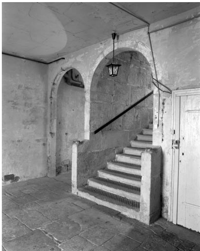
Détail de l'escalier, de trois quarts droit.
