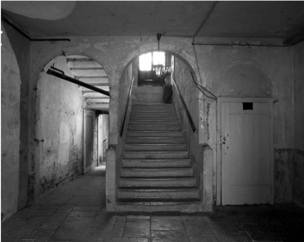
Détail de l'escalier, de face.
