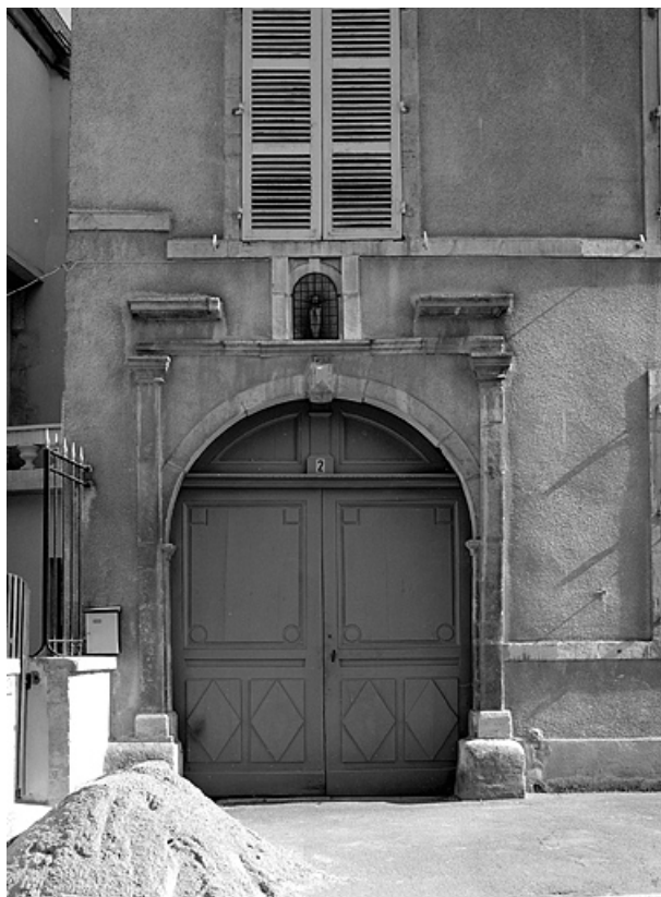
Détail du portail d'entrée.
