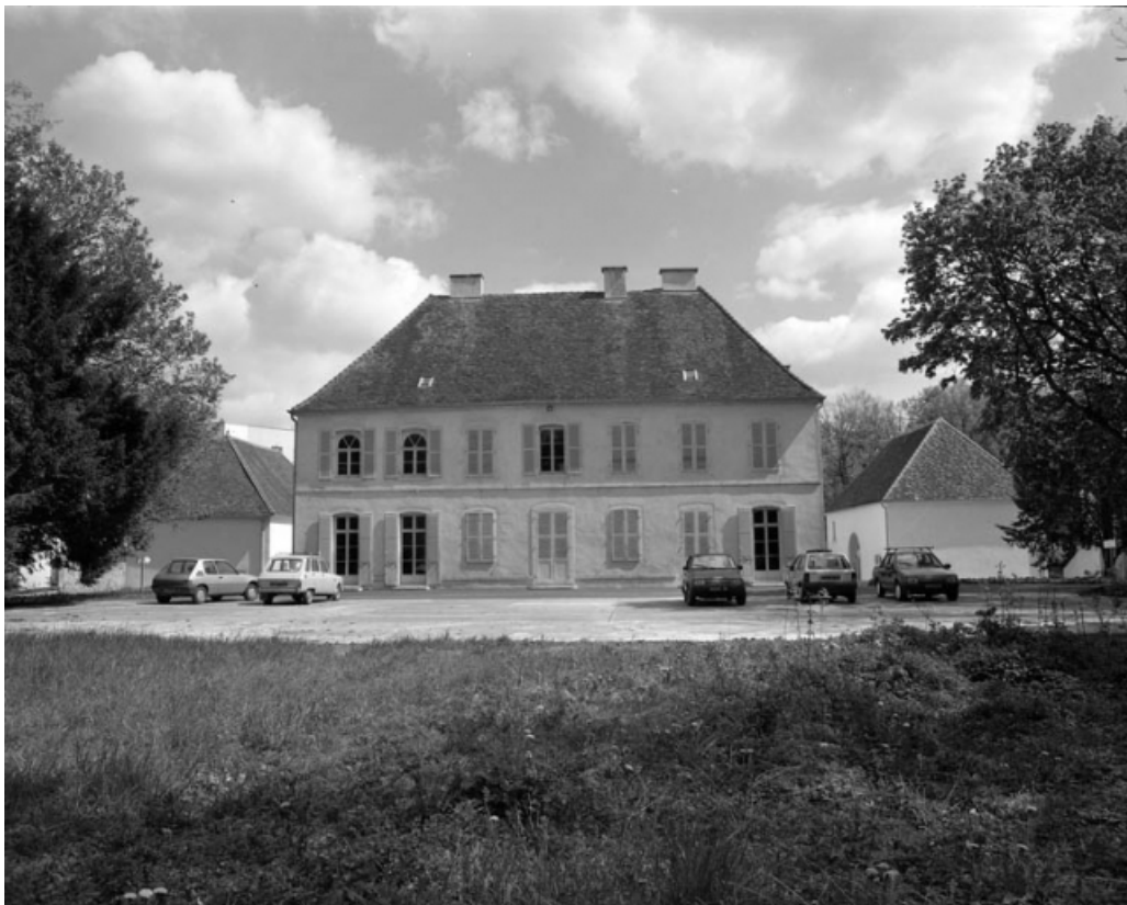
Façade postérieure depuis le parc.
