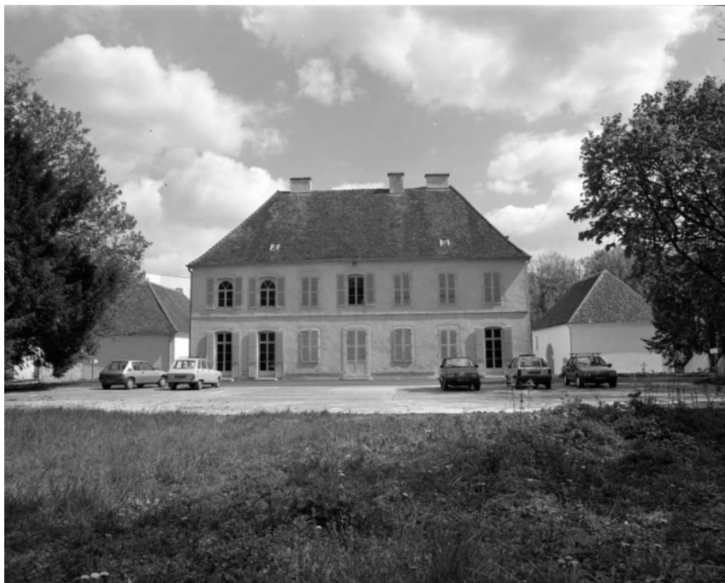
Façade postérieure depuis le parc.
