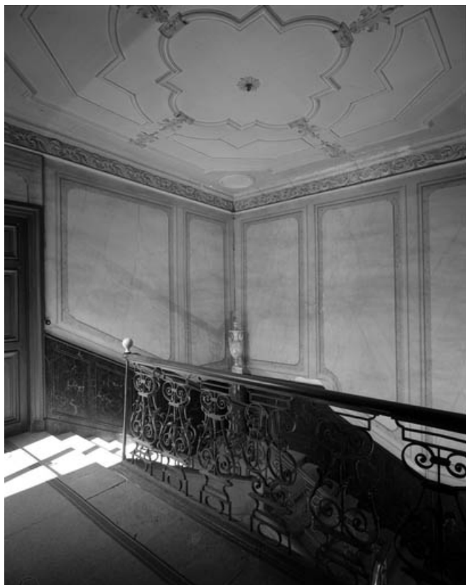
Détail de la cage de l'escalier d'honneur, depuis le premier étage. 70, Gray, 9 rue Jobard
