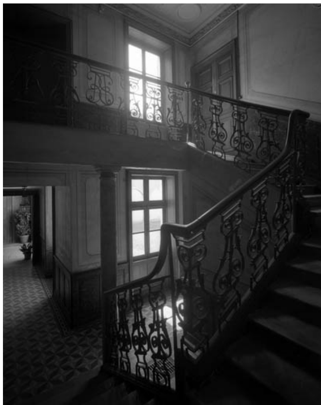
Escalier d'honneur : vue d'ensemble.
