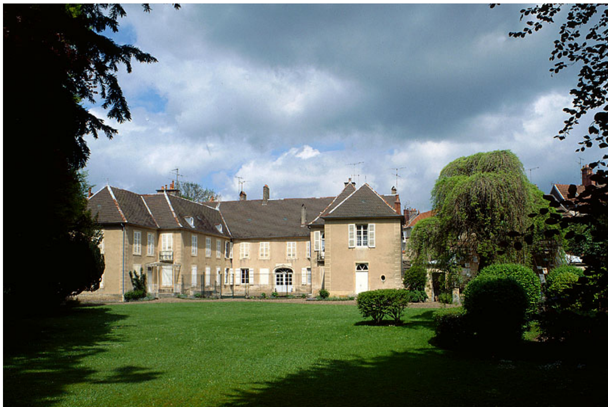
Vue de la façade postérieure depuis le parc.
