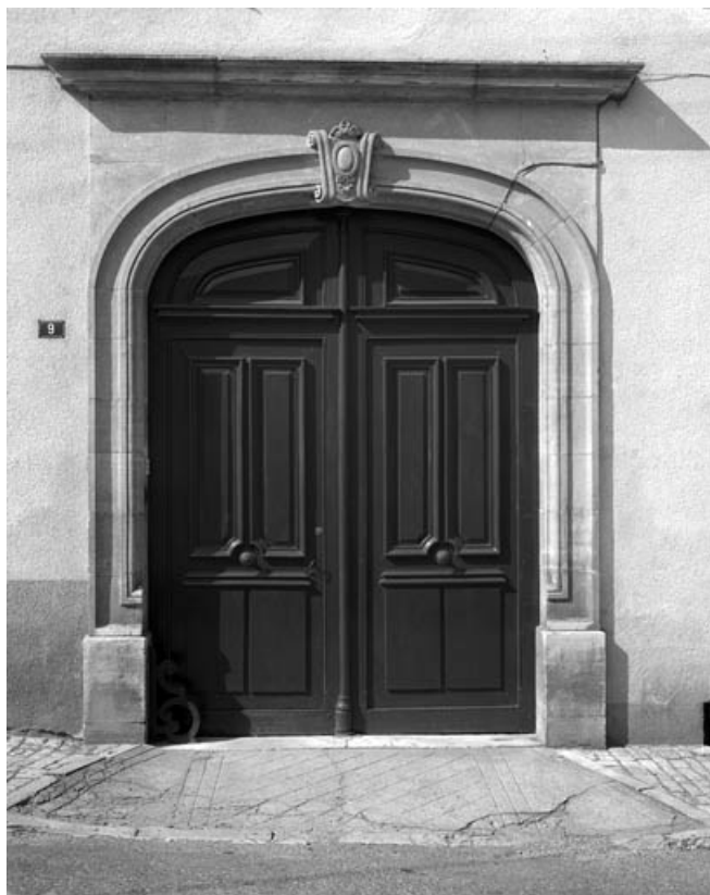
Détail de la porte d'entrée sur rue, de face.
