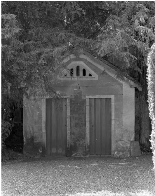
Détail des lieux d'aisance destinés au personnel.
