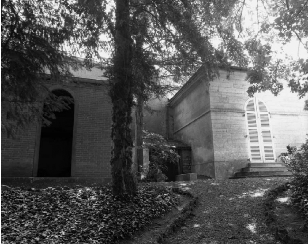
Détail du salon de musique et de la remise à mobilier de jardin situés au fond du parc. 70, Gray, 9 rue Jobard
