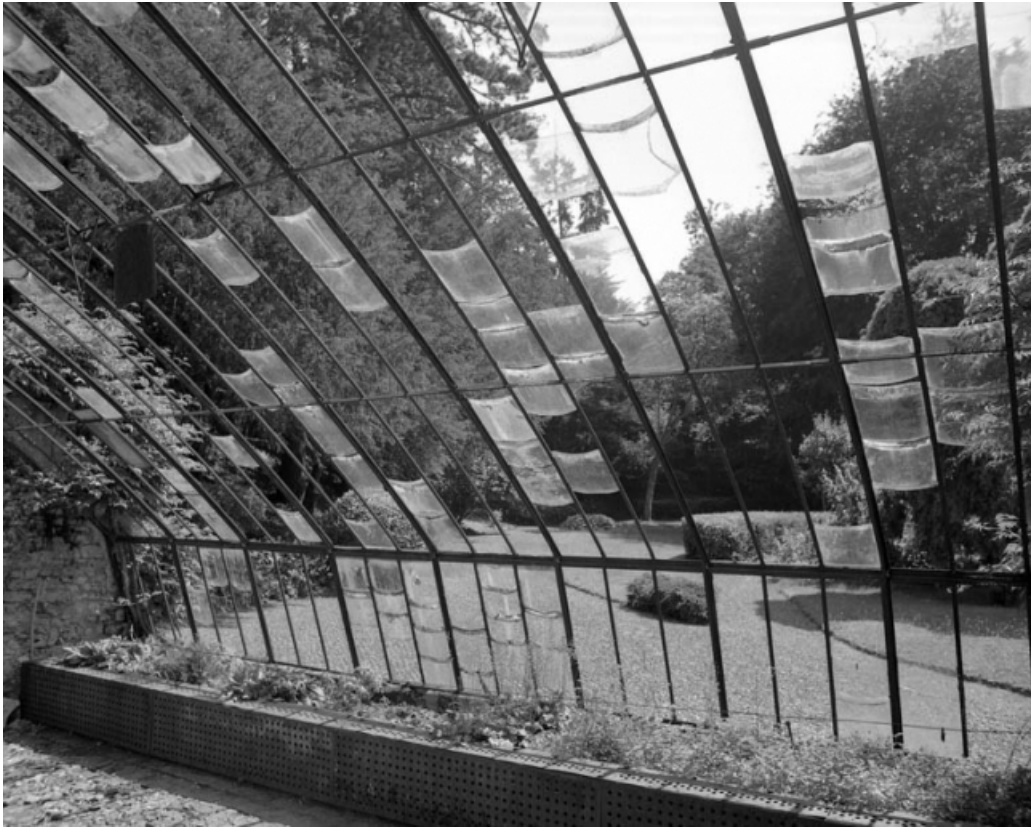
Serre : détail de la verrière.
