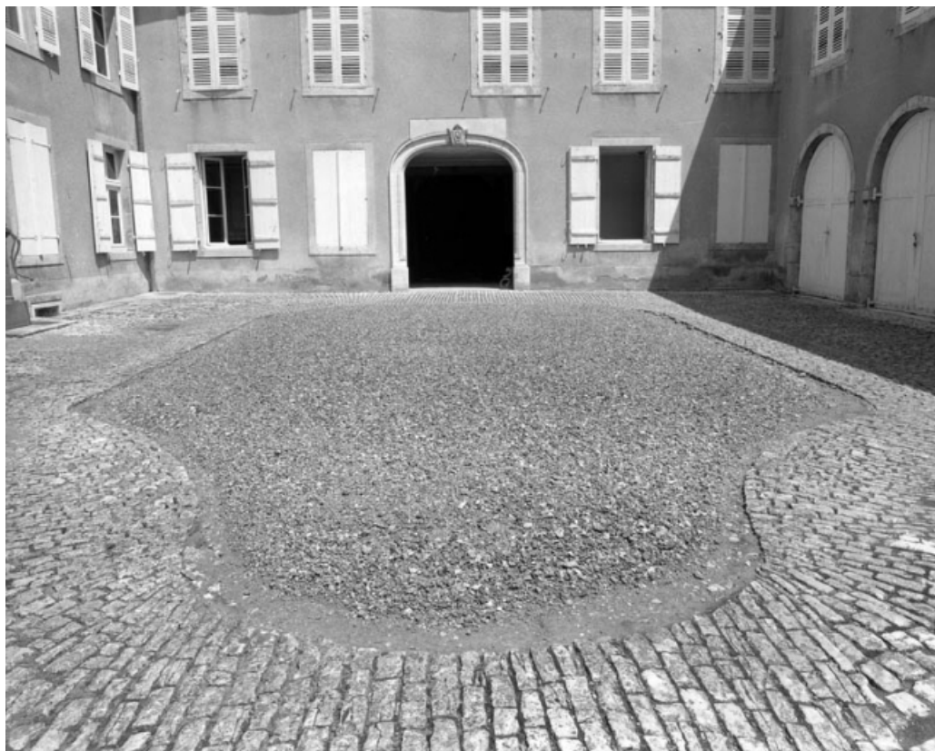
Vue d'ensemble de la cour depuis la grille du parc.
