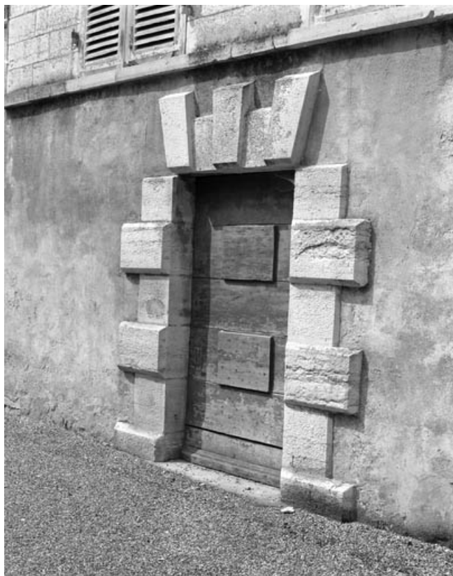
Le salon de musique : façade latérale droite, détail de la porte donnant sur l'avenue Revon. 70, Gray, 9 rue Jobard
