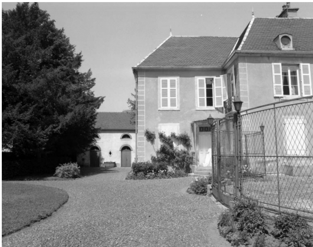
Vue de l'extrémité de l'aile droite depuis l'entrée du parc.
