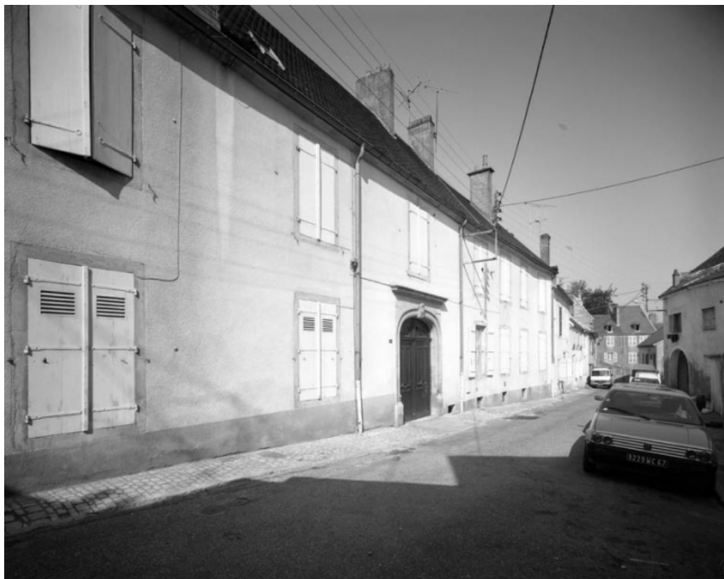
Façade sur rue, de trois quarts gauche.
