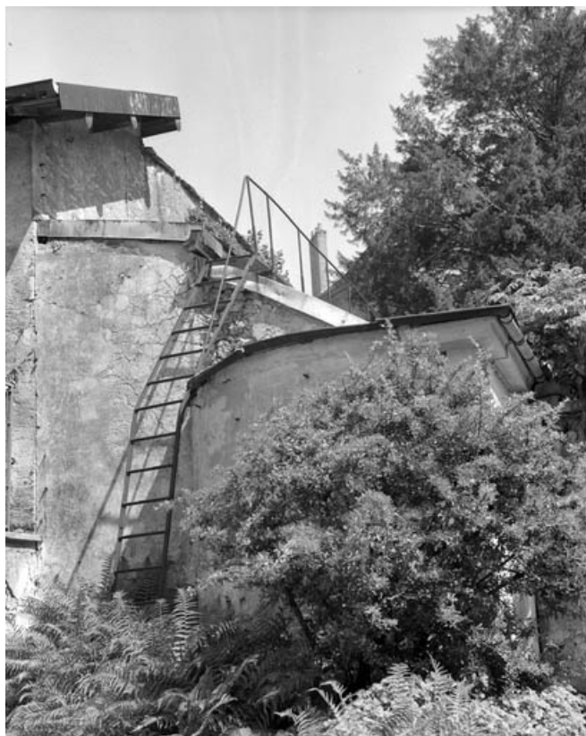
Serre : détail de l'escalier desservant le sommet de l'édifice. 70, Gray, 9 rue Jobard
