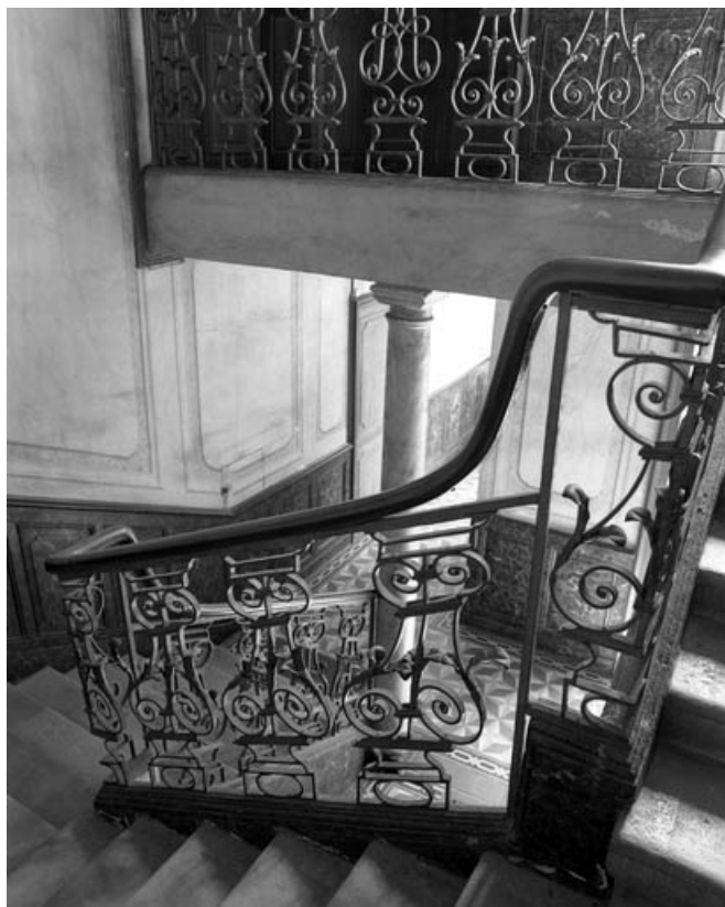
Escalier d'honneur : détail de la rampe d'escalier.
