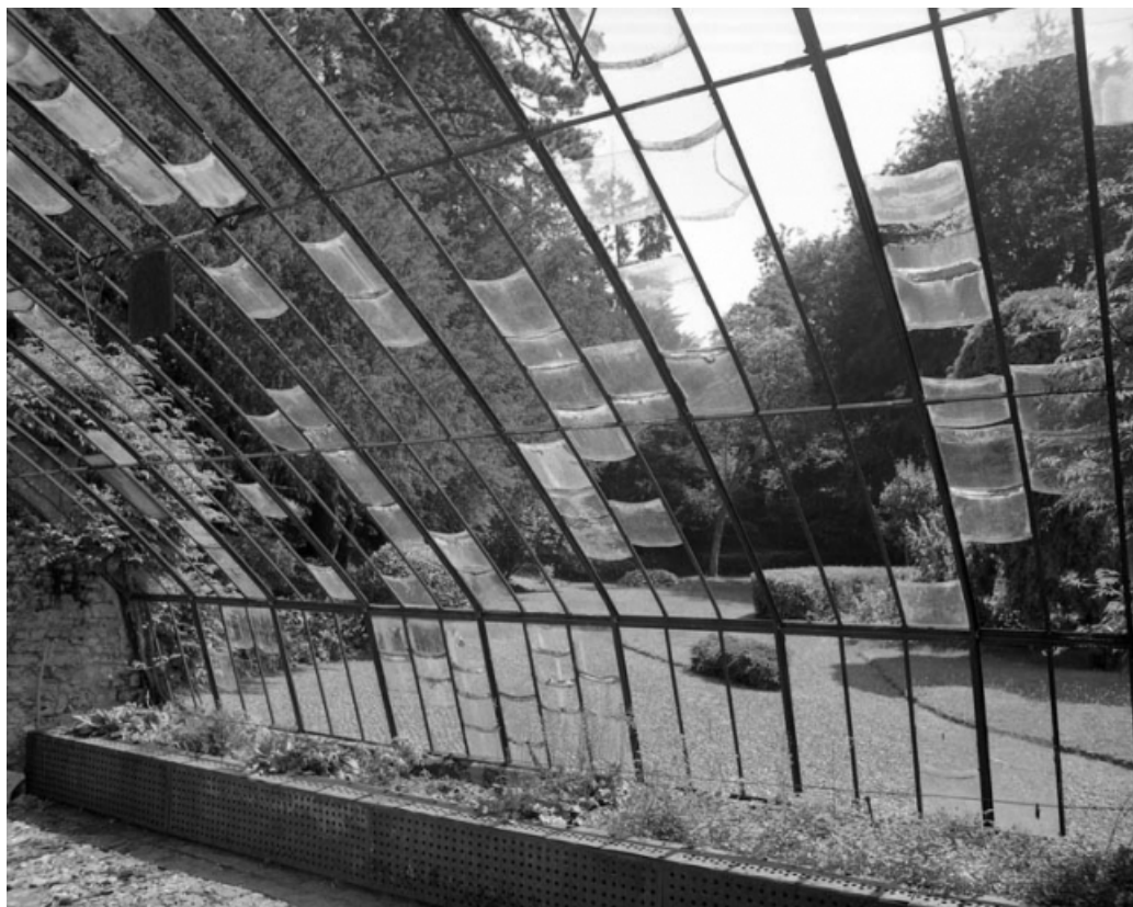
Serre : détail de la verrière.
