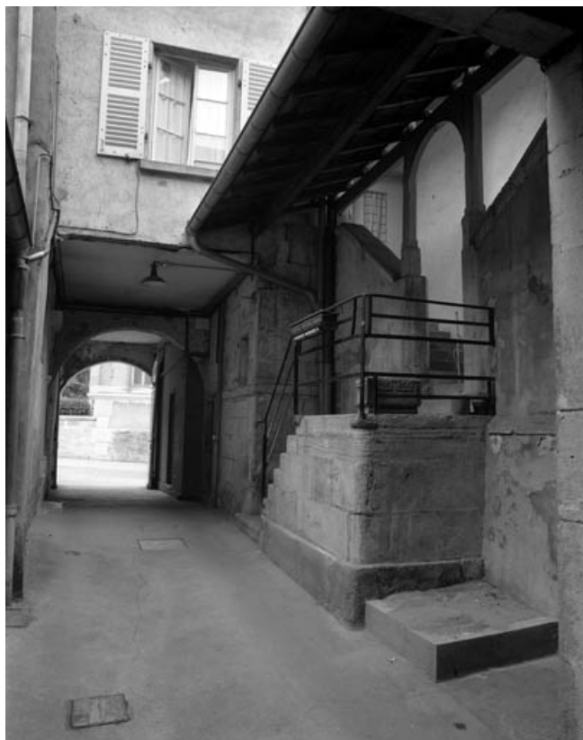
Escalier extérieur et porche d'entrée depuis le fond de la cour. 70, Gray Grande Rue 72
