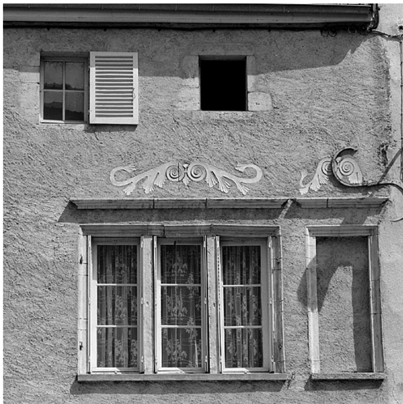
Détail : baies du premier étage à droite de la façade.
