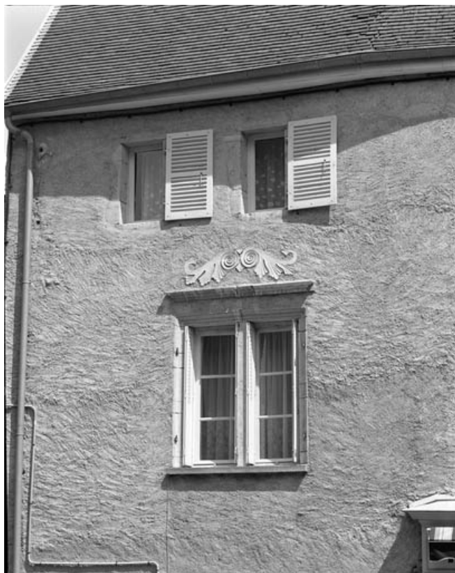
Détail : baie du premier étage à gauche de la façade. 70, Gray Grande Rue 72
