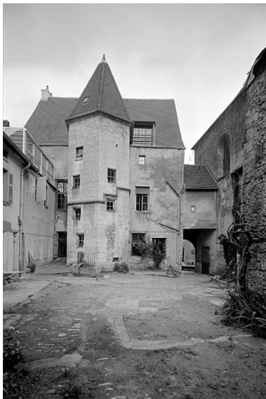
Façade postérieure avec tour d'escalier hors-oeuvre.
