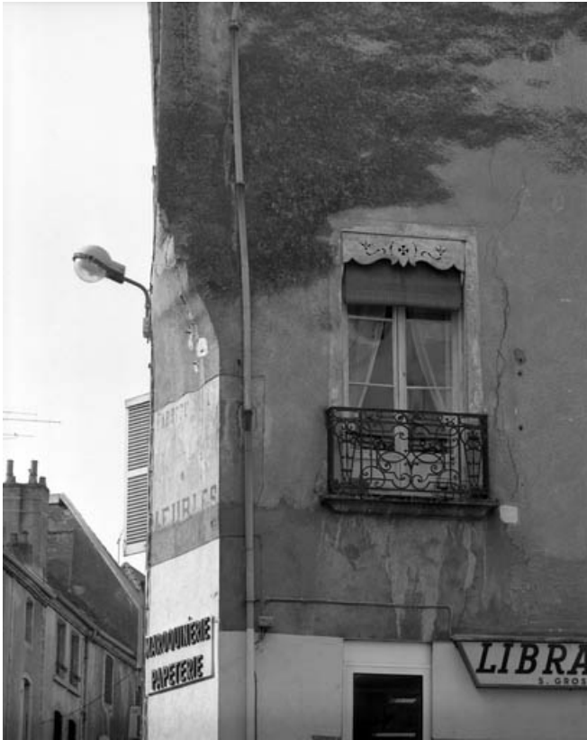
Détail : mur à angle coupé et en encorbellement entre la façade antérieure et la façade latérale droite. 70, Gray Grande Rue 69, 71
