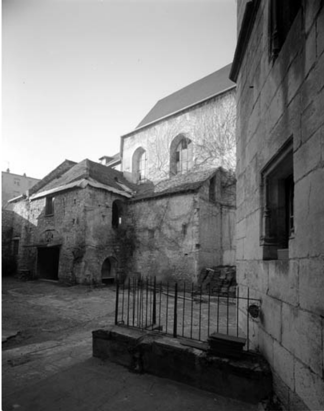
Vue d'ensemble de la remise à droite de la cour.
