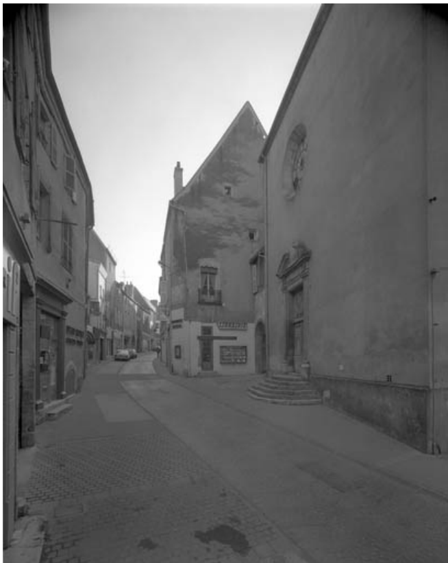
Façade latérale droite depuis la Grande rue.
