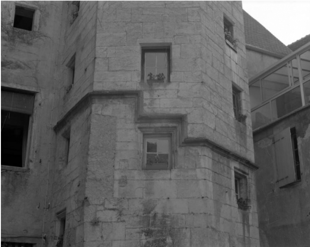
Façade postérieure. Détail : baies de l'escalier hors-oeuvre.
