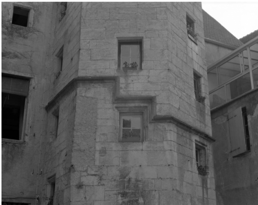
Façade postérieure. Détail : baies de l'escalier hors-oeuvre.
