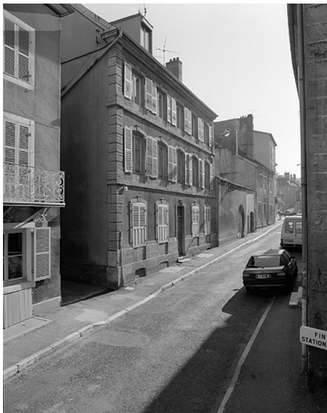
Façade antérieure de trois quarts gauche. 70, Gray Grande Rue 30
