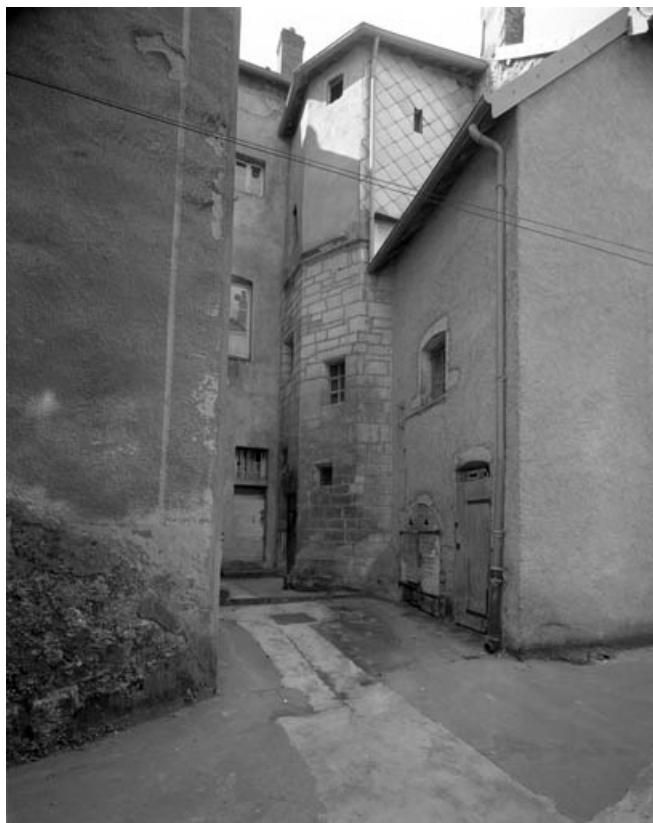
Vue de la tour d'escalier sur la façade postérieure.
