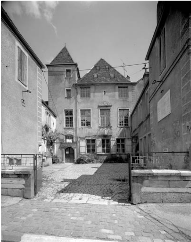
Façade antérieure du corps de bâtiment principal.
