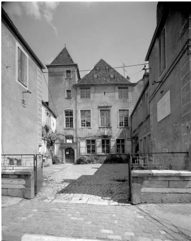
Façade antérieure du corps de bâtiment principal.
