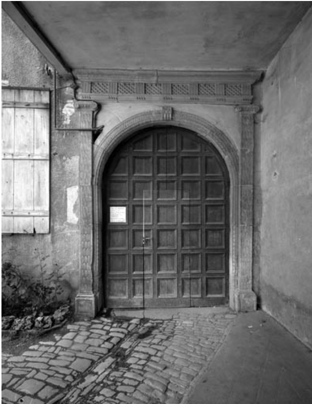
Détail : porte cochère sur façade antérieure du corps de bâtiment principal. 70, Gray, 11 rue des Casernes
