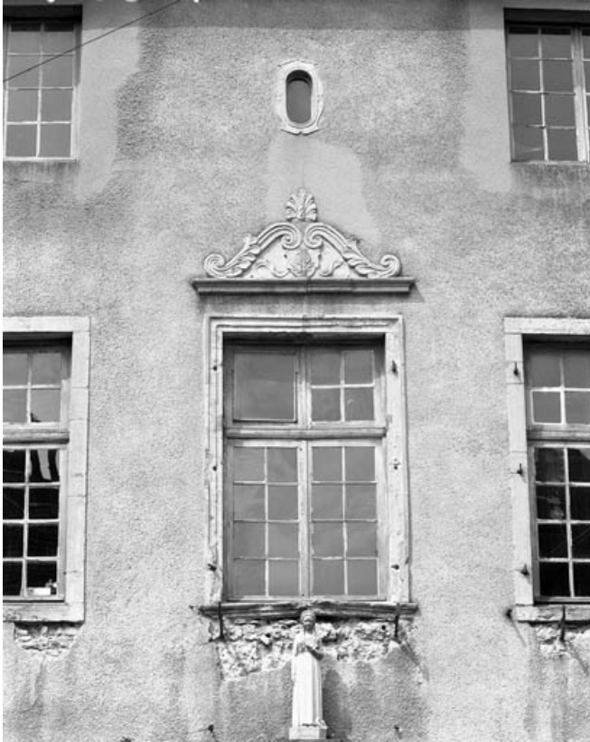
Détail d'une baie du premier étage : façade antérieure du corps de bâtiment principal. 70, Gray, 11 rue des Casernes
