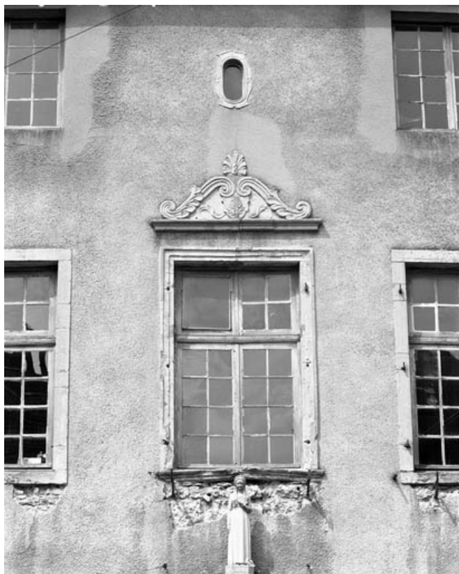
Détail d'une baie du premier étage : façade antérieure du corps de bâtiment principal. 70, Gray, 11 rue des Casernes
