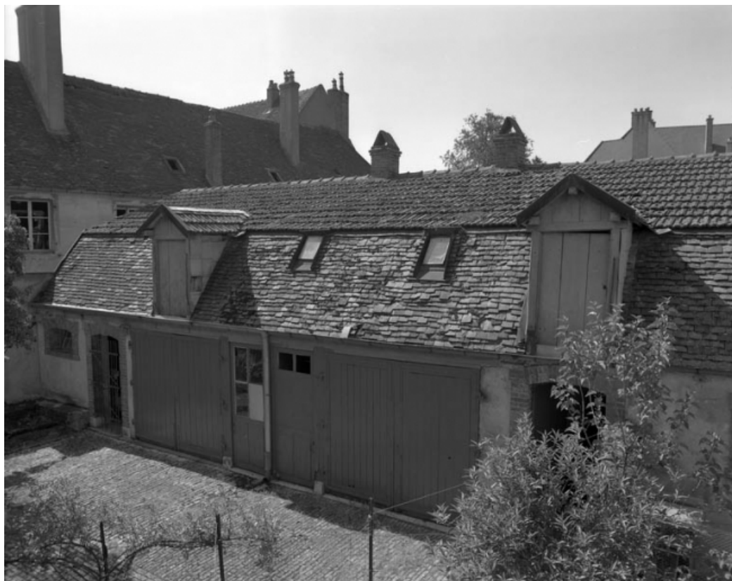
Bâtiment annexe construit dans la cour, autrefois jardin régulier.
