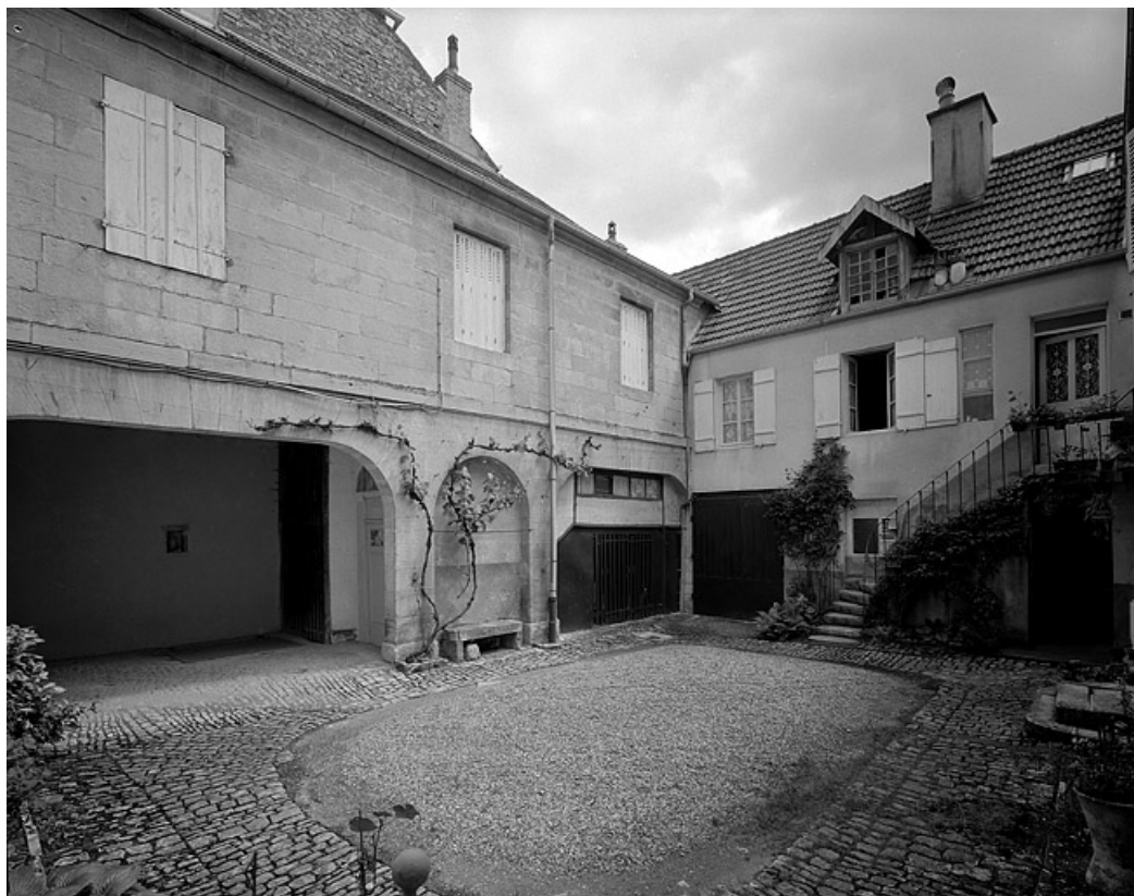
Aile gauche et bâtiment en fond de cour.
