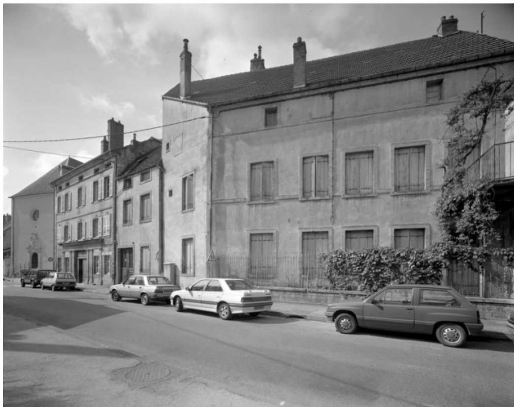
Façade antérieure sur rue, de trois quarts droit.
