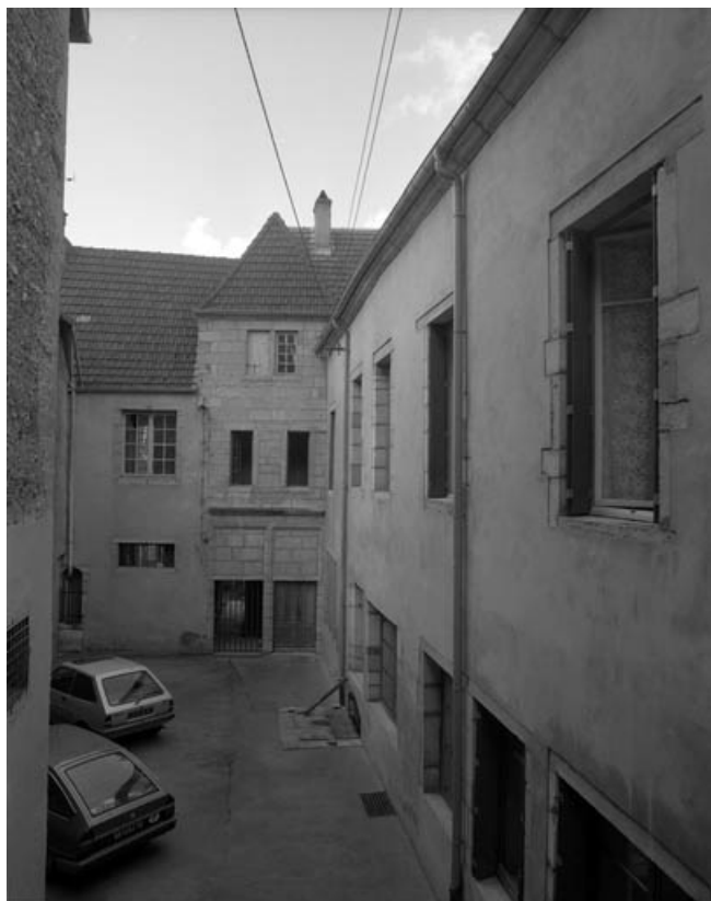
Aile droite et corps de bâtiment en fond de cour, depuis le portail d'entrée. 70, Gray, 2 rue des Casernes
