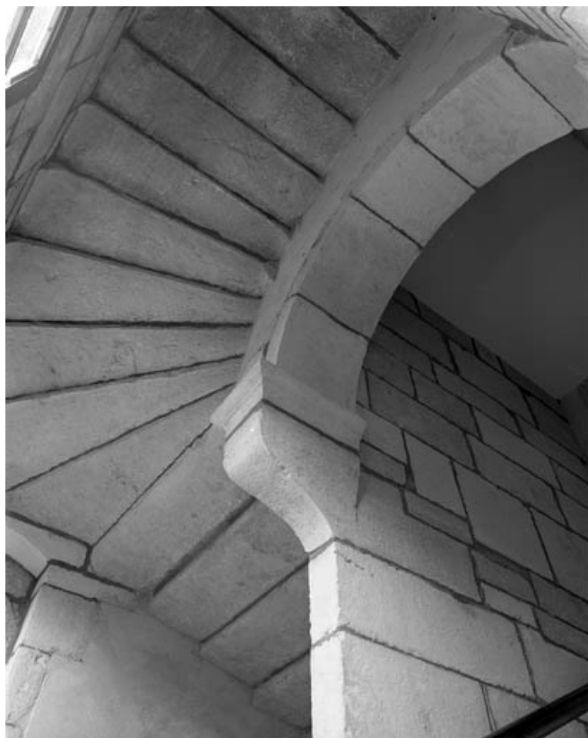
Détail d'une volée d'escalier.
