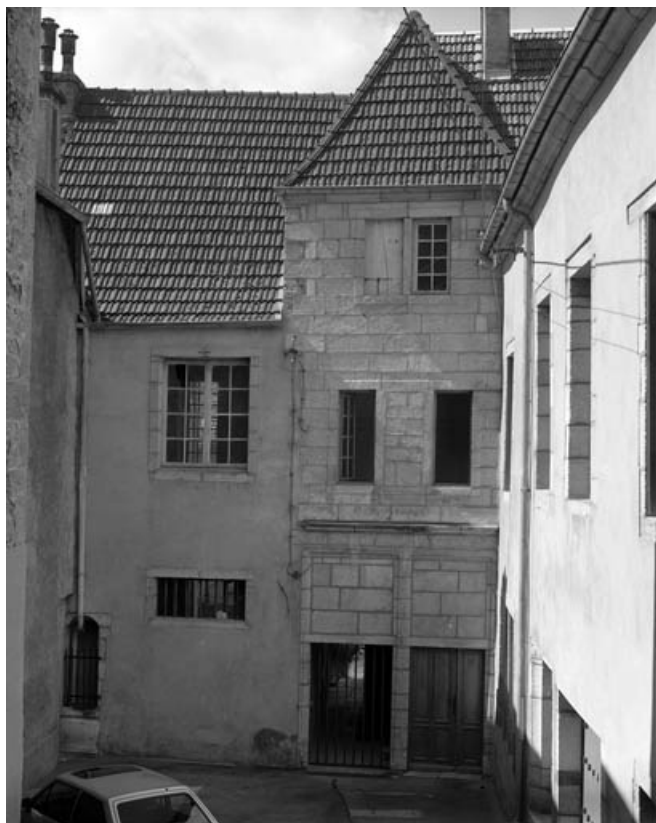
Façade antérieure du corps de bâtiment en fond de cour contenant l'escalier. 70, Gray, 2 rue des Casernes
