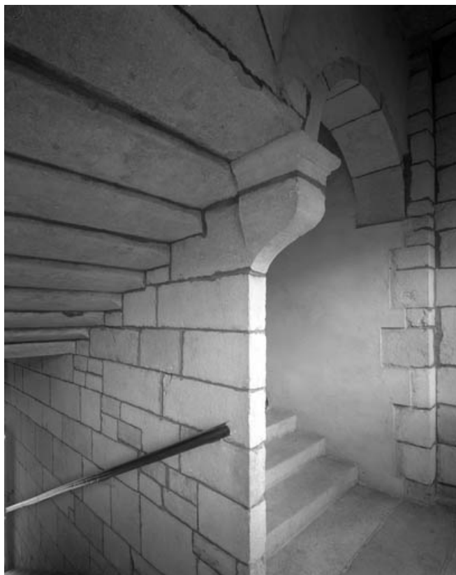
Détail de la montée d'escalier.
