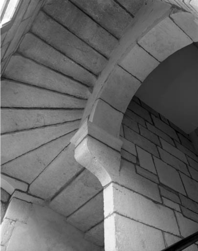
Détail d'une volée d'escalier.
