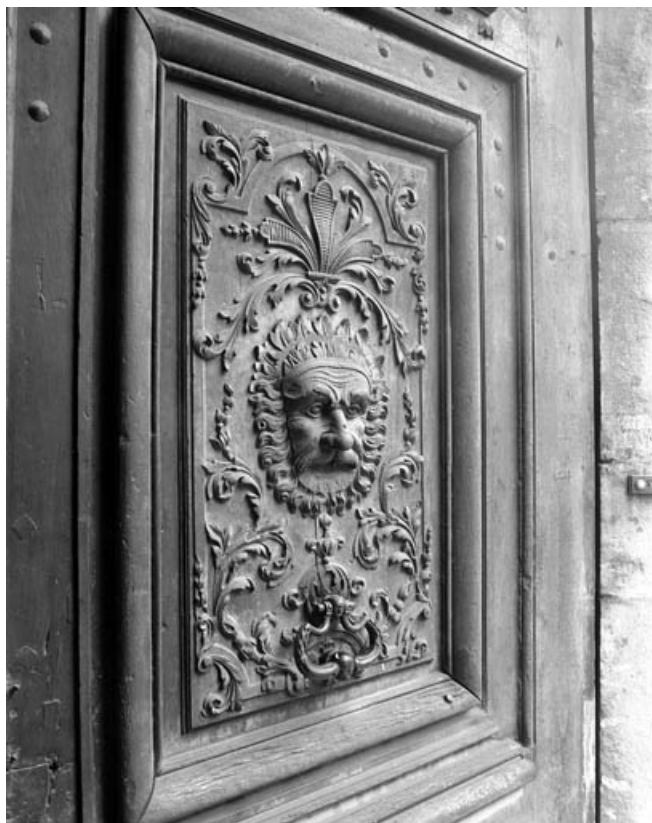
Détail du portail d'entrée : panneau central droit de trois quarts gauche. 70, Gray, 14 rue des Casernes
