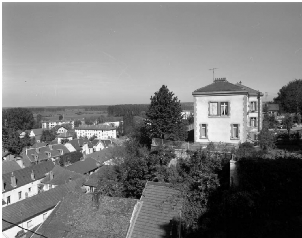
Vue d'ensemble montrant la situation dominante de l'édifice.
