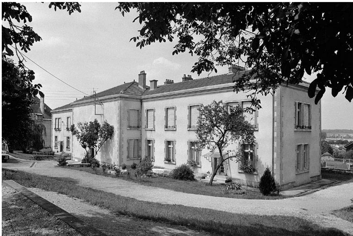
Logement : de trois quarts droit. 70, Gray rue Signard
