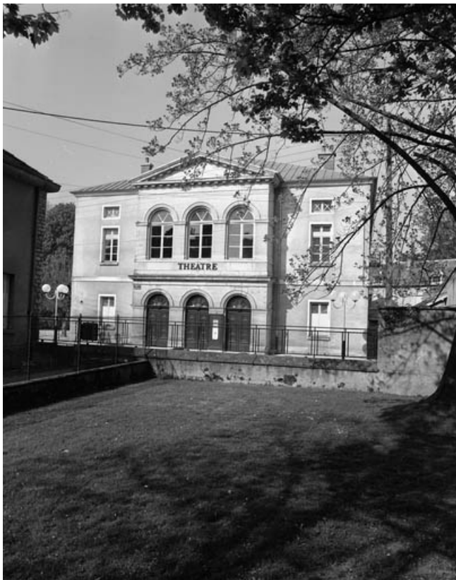
Façade antérieure depuis le parc de la Maison des Associations Grayloises. 70, Gray rue Victor Hugo
