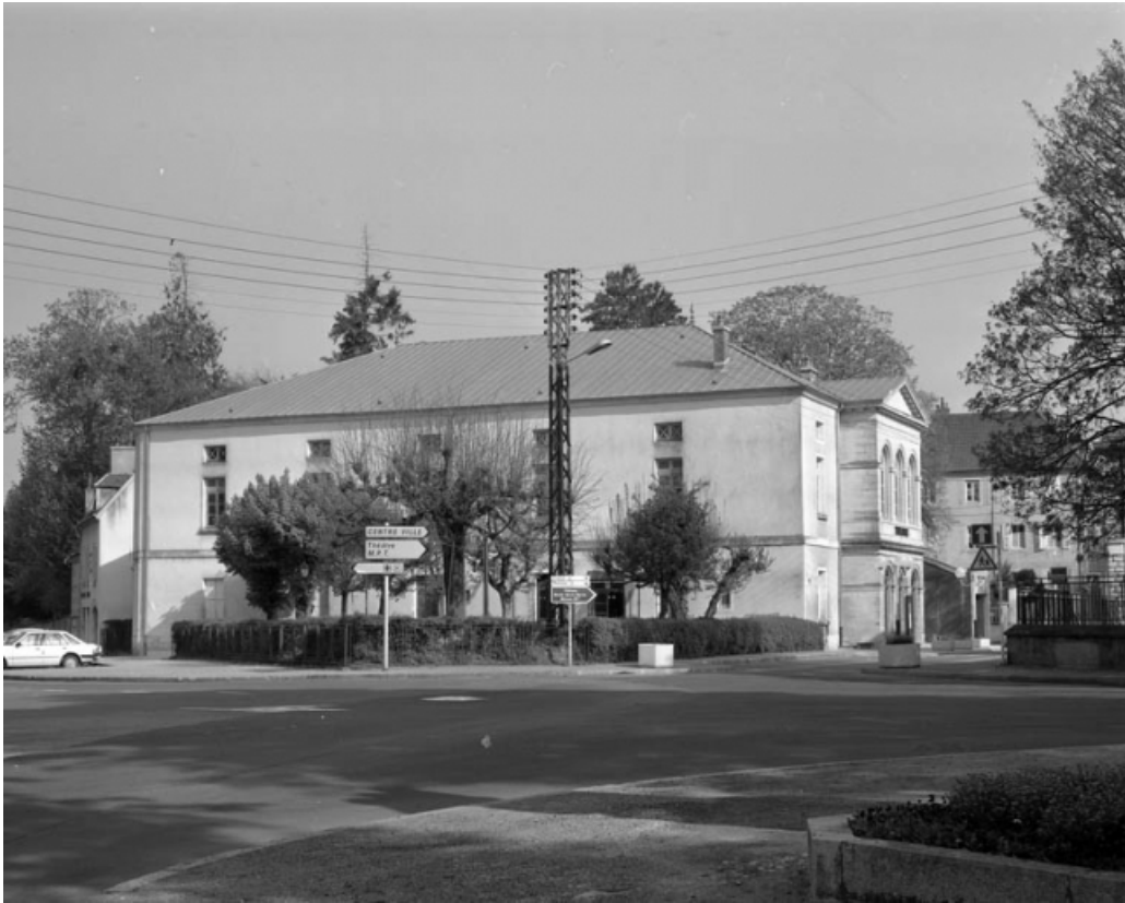
Façades antérieure et latérale gauche.
