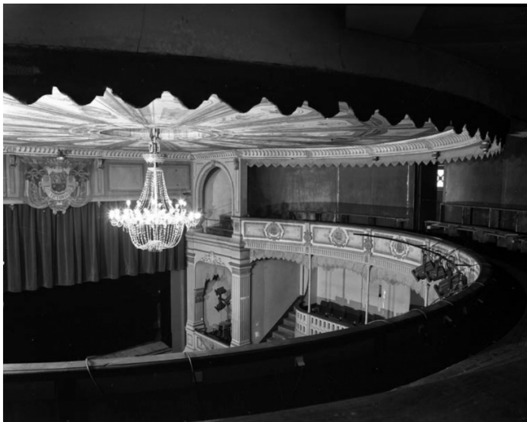
Intérieur : vue du plafond et du deuxième balcon, de trois quarts gauche. 70, Gray rue Victor Hugo
