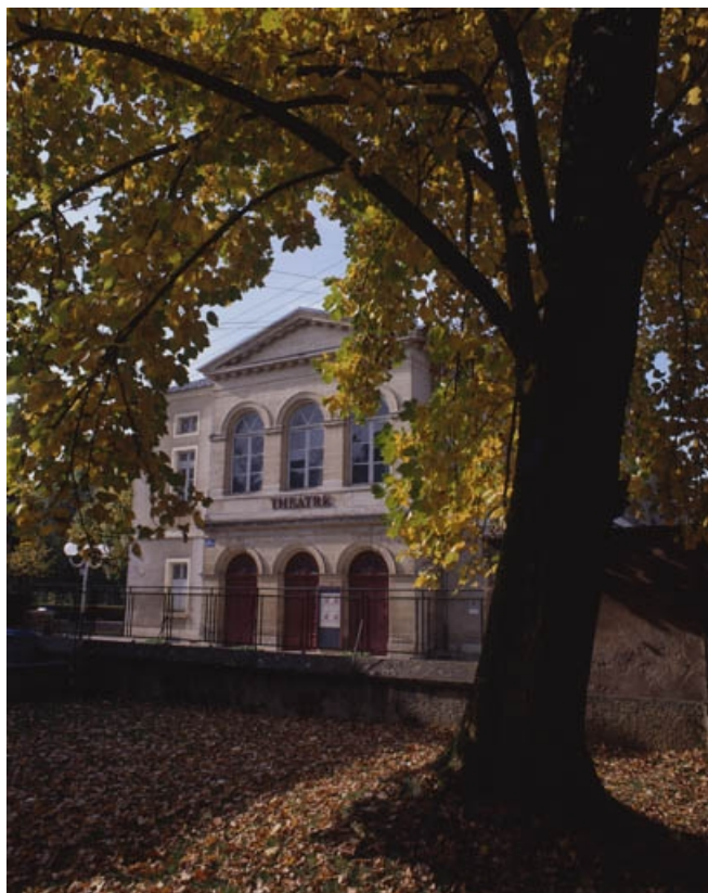
Façade antérieure de trois quarts droit : vue éloignée.
