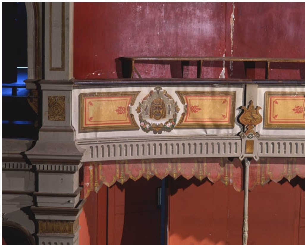
Intérieur : détail du décor au-dessus du premier balcon.
