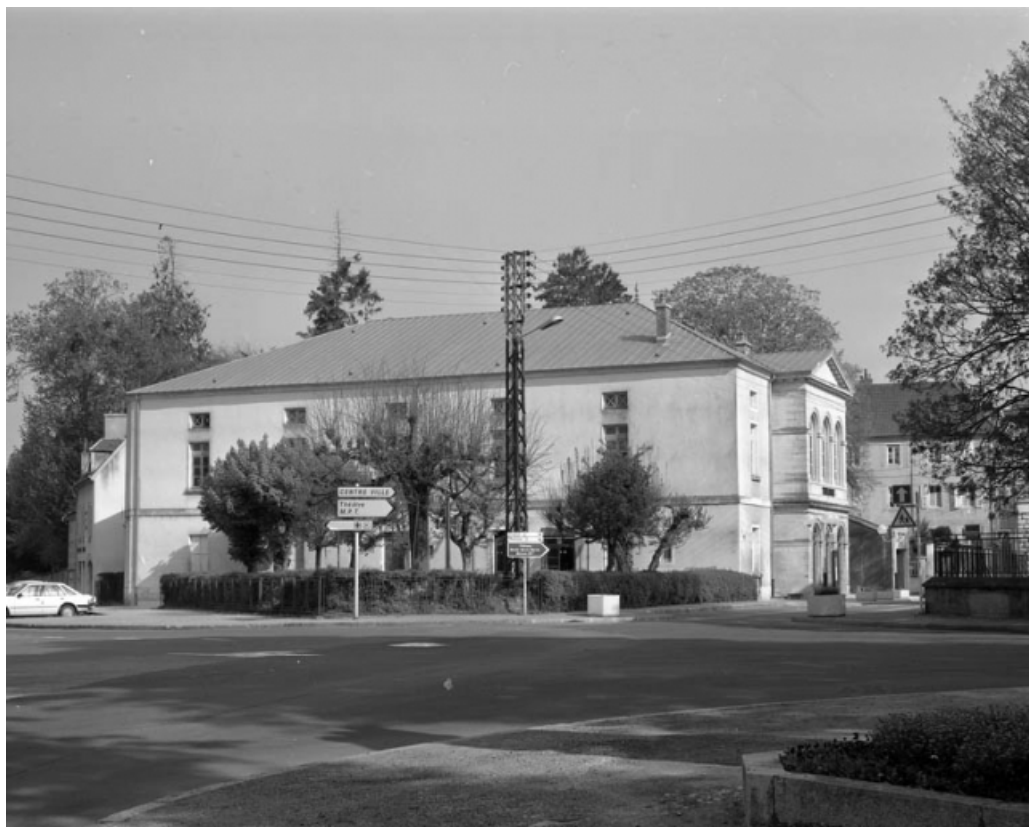
Façades antérieure et latérale gauche.
