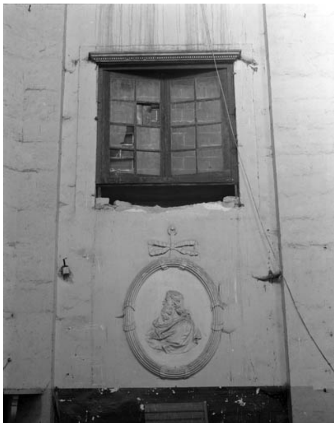
Chapelle : intérieur, façade latérale droite avec médaillon de saint Paul? surmonté d'une baie murée. 70, Gray Grande Rue 73
