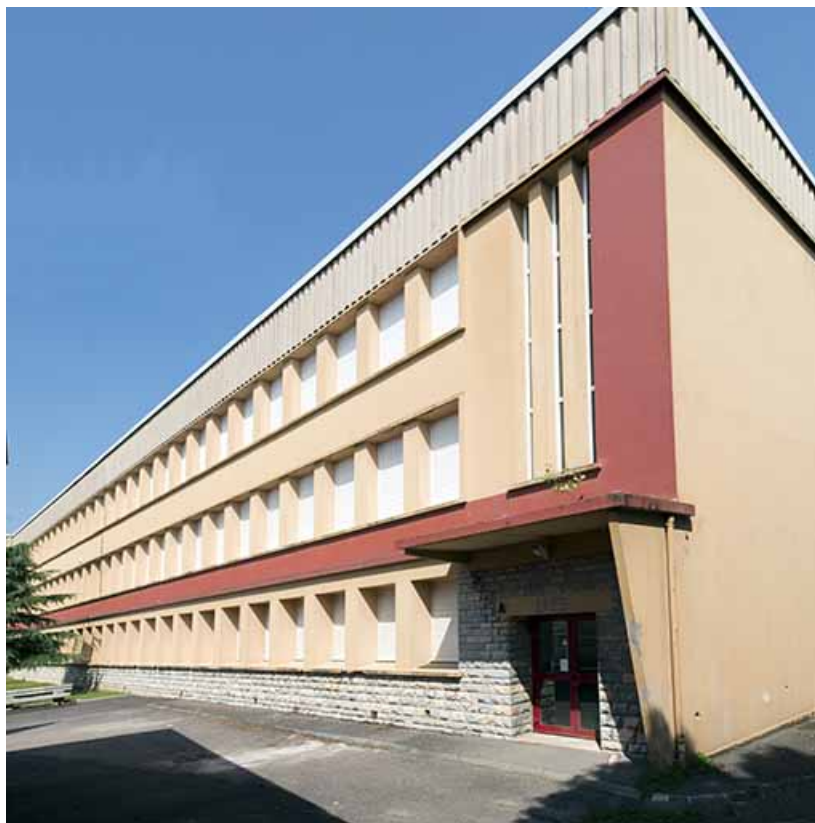
Angle sud-est de la barre d'externat nord. 70, Gray Grande Rue 73
