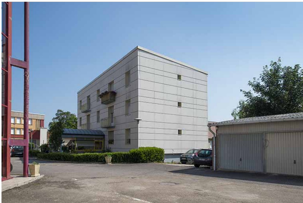
Angle sud-ouest du bâtiment d'accueil, de la loge et des logements. 70, Gray Grande Rue 73
