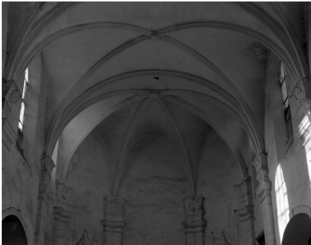
Chapelle : intérieur, voûtes du chœur.
