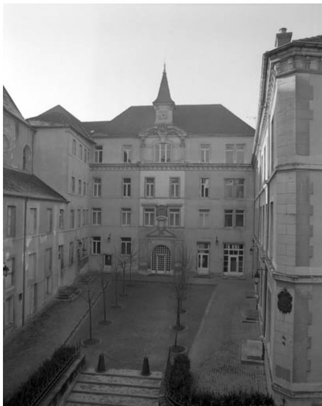
Façade antérieure du bâtiment principal.
