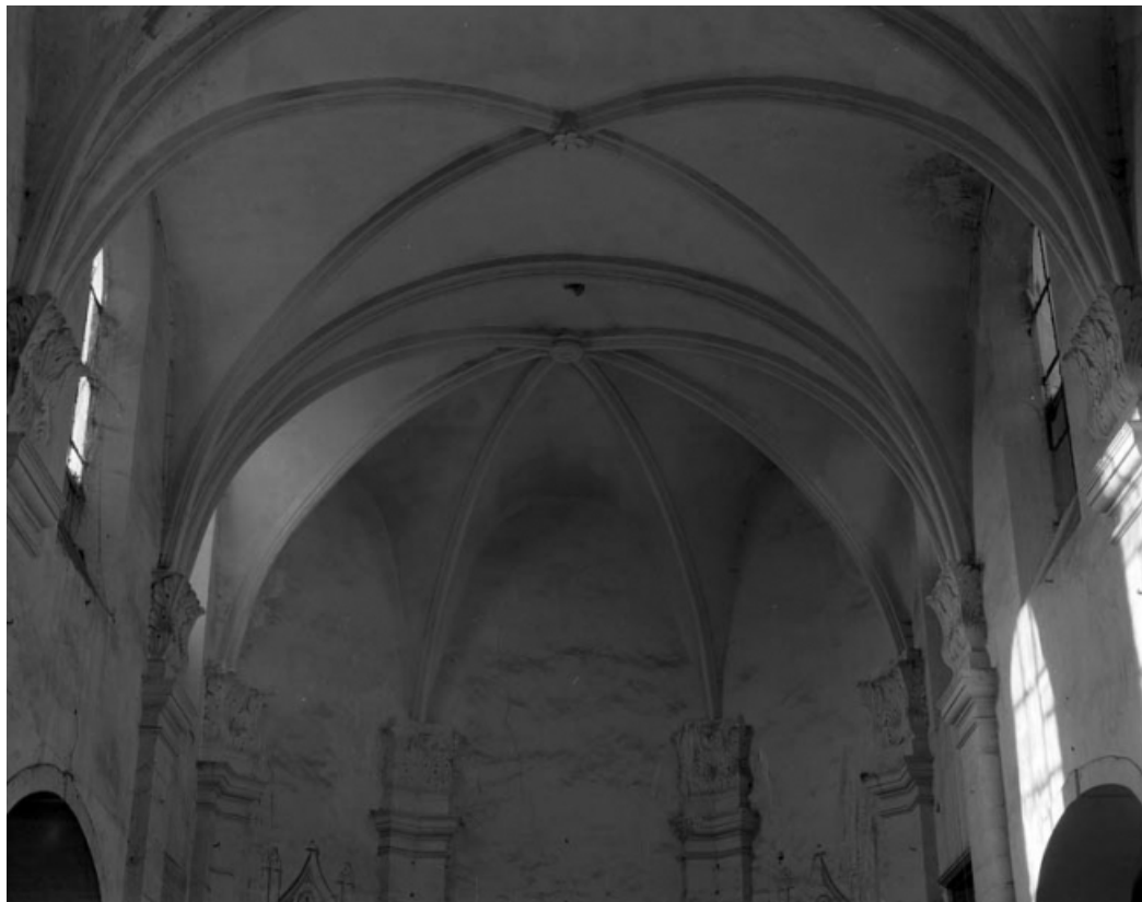
Chapelle : intérieur, voûtes du choeur.
