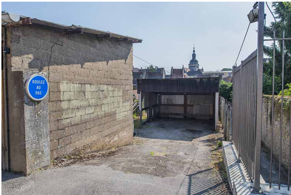
Détail de façade sud des garages et entrée ouest du garage des ouvriers. 70, Gray Grande Rue 73
