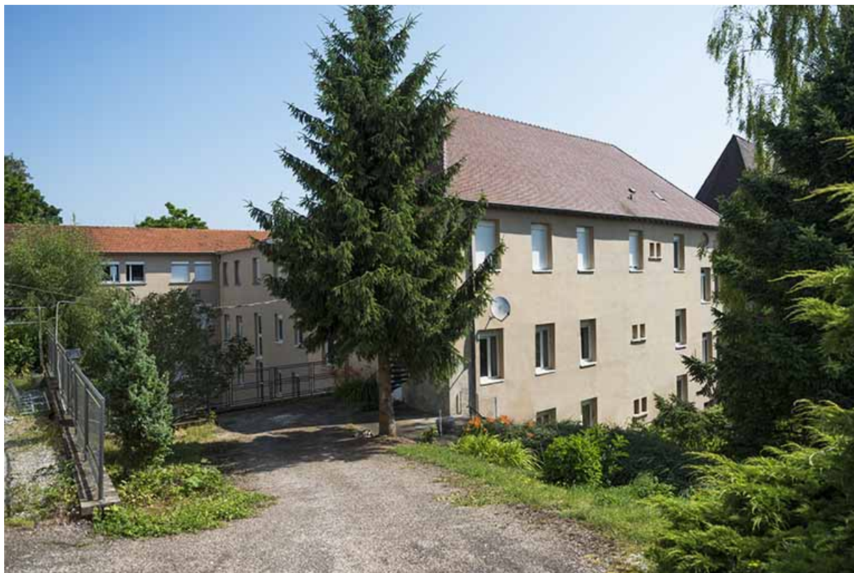
Angle sud-ouest du bâtiment d'administration.
