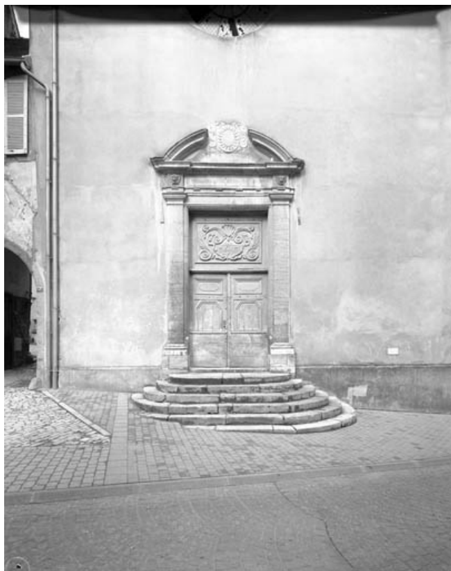
Chapelle : façade antérieure, détail du portail d'entrée.
