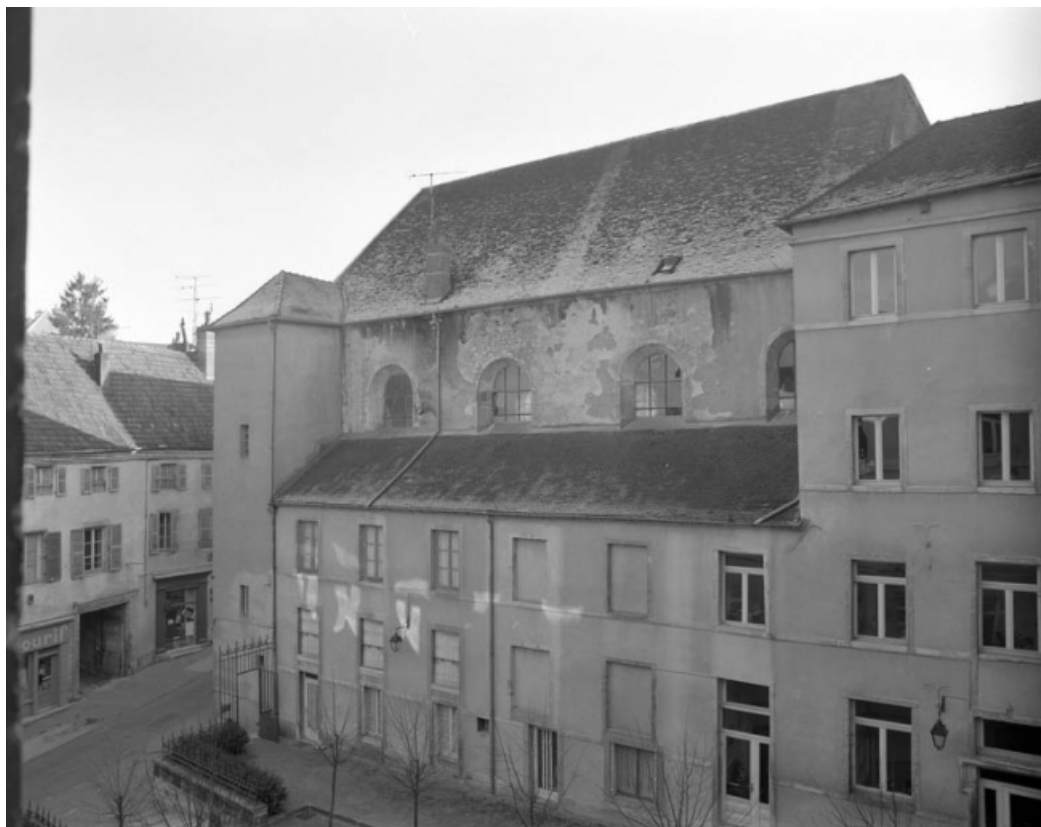
Aile gauche et façade latérale droite de la chapelle.
