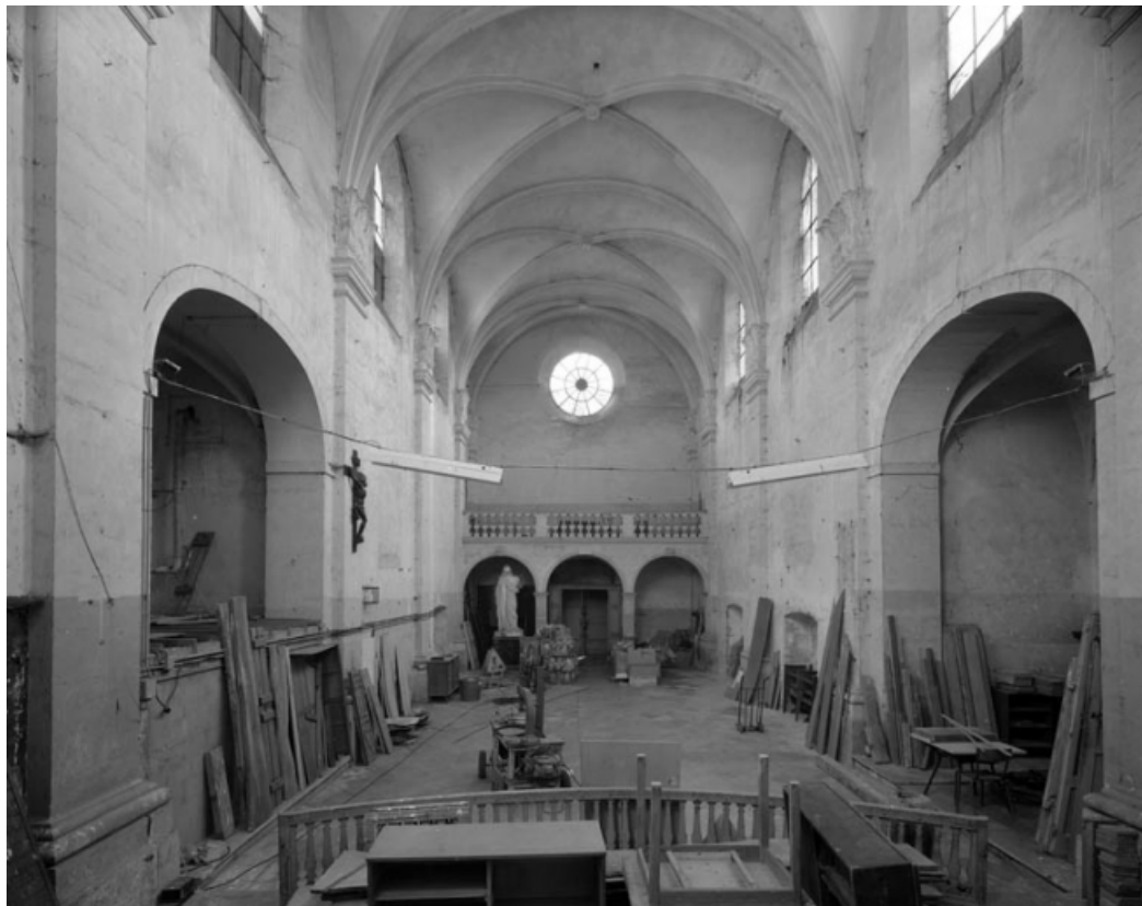
Chapelle : intérieur, nef depuis le chœur avec chapelles latérales. 70, Gray Grande Rue 73
