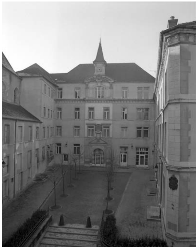
Façade antérieure du bâtiment principal.
