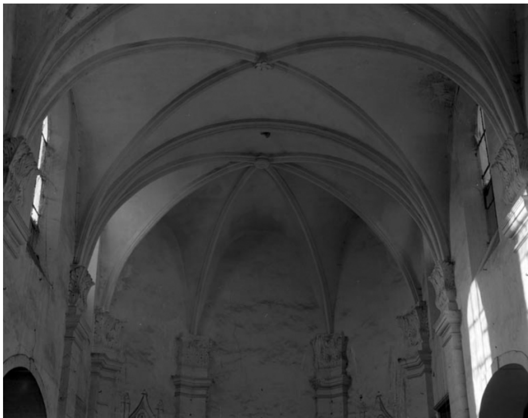
Chapelle : intérieur, voûtes du chœur.
