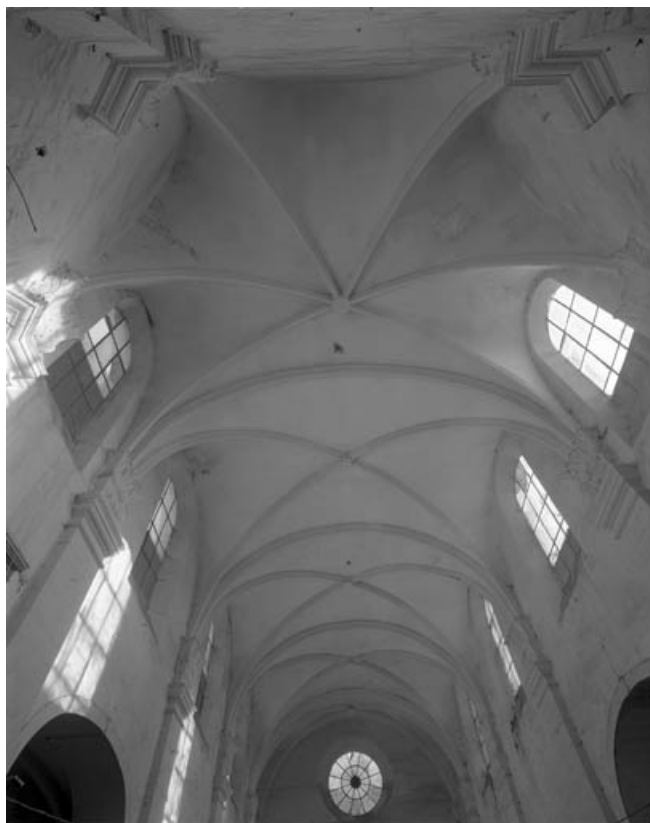
Chapelle : intérieur, voûtes du choeur et de la nef.
