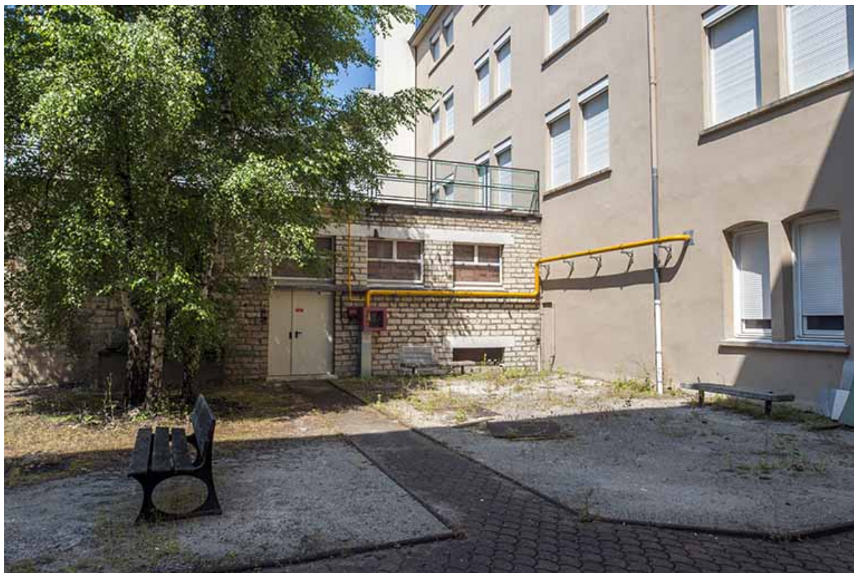
Angle nord-ouest de la petite cour d'honneur, chaufferie, ancien internat. 70, Gray Grande Rue 73
