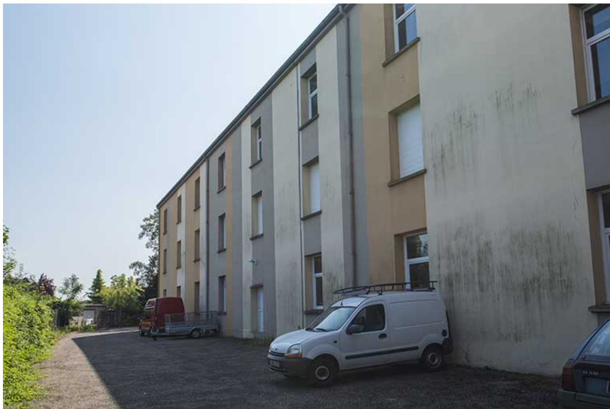
Façade nord de la barre d'externat nord. 70, Gray Grande Rue 73
