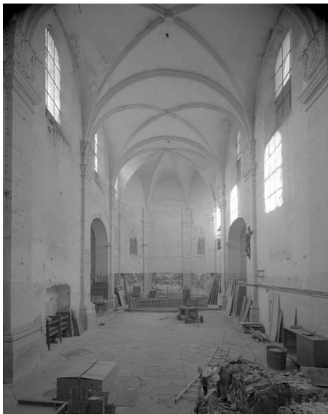
Chapelle : intérieur, nef et chœur.
