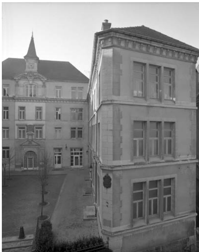
Aile droite et façade antérieure du bâtiment principal.
