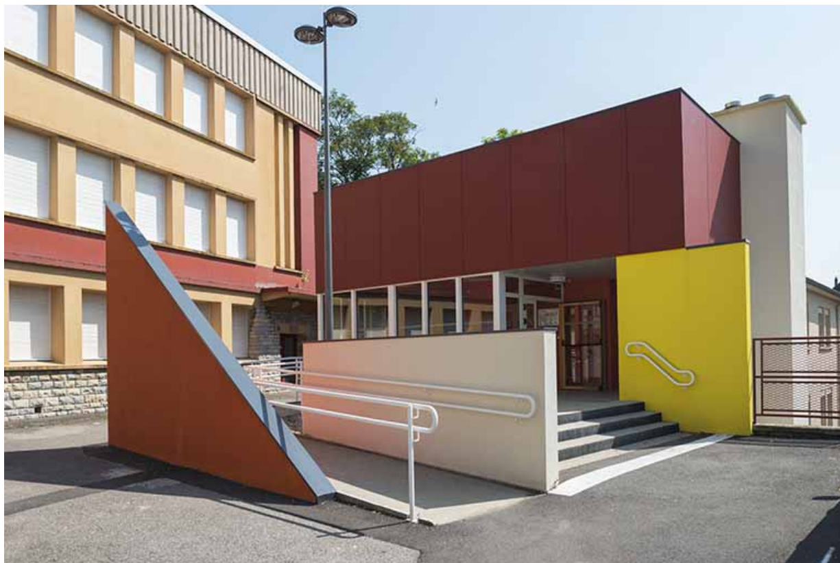
Angle est de la barre d'externat nord et entrée du centre de documentation et d'information. 70, Gray Grande Rue 73
