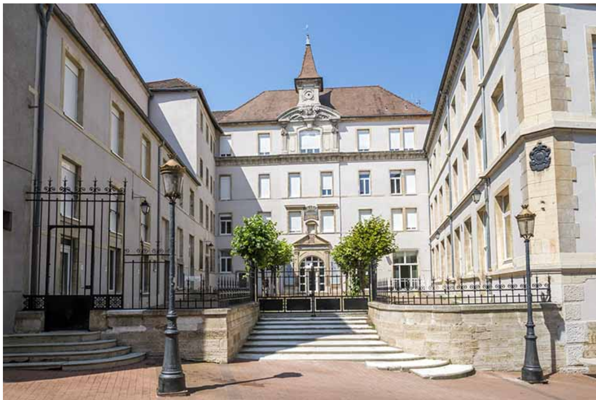
Façade antérieure du bâtiment principal sur la grande rue.
