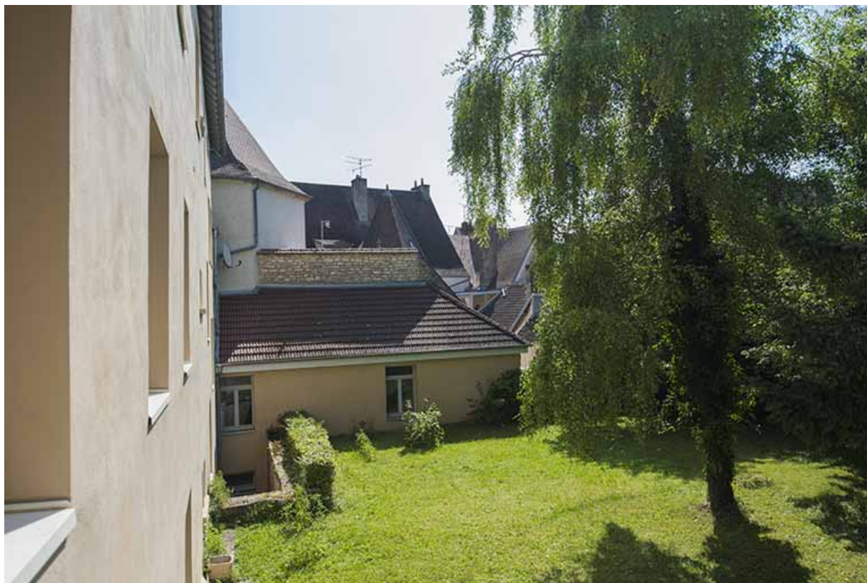
Angle nord-est du jardin, façades ouest du bâtiment des archives, façade sud du bâtiment d'administration. 70, Gray Grande Rue 73
