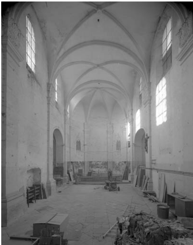
Chapelle : intérieur, nef et chœur.
