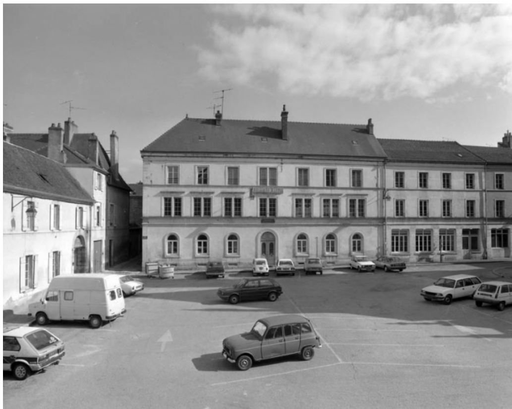
Façade antérieure de face : vue éloignée.
