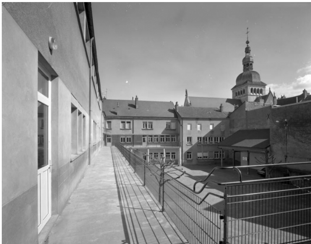
Façade postérieure du bâtiment donnant place de la Sous-Préfecture, depuis le fond de la cour. 70, Gray place de la Sous-Préfecture
