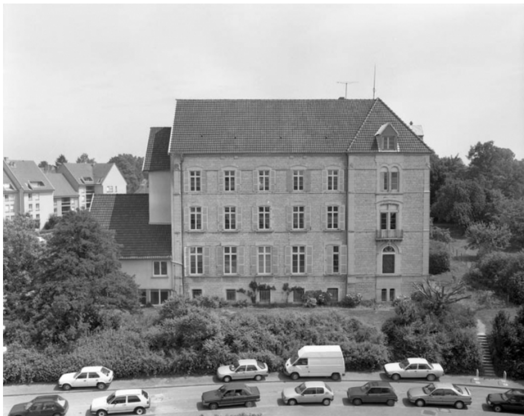
Vue d'ensemble de la façade postérieure depuis le nouvel hôpital. 70, Gray rue de l' Arsenal
