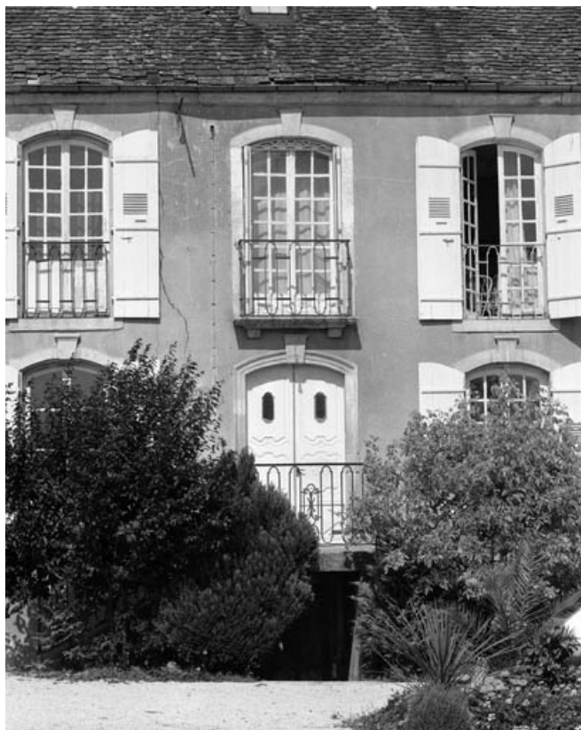
Détail de la partie centrale de la façade antérieure.
