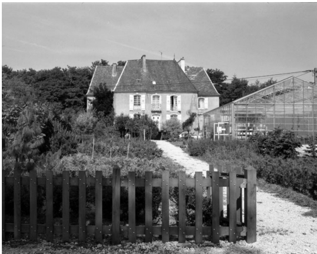
Vue d'ensemble de face depuis la rue.
