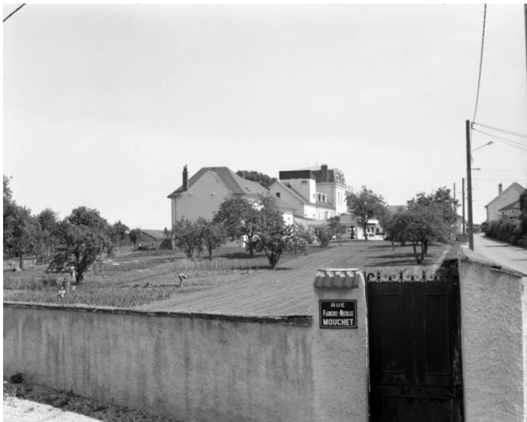
Vue éloignée depuis la rue Mouchet avec la clôture délimitant la propriété. 70, Gray rue de la Vieille Tuilerie
