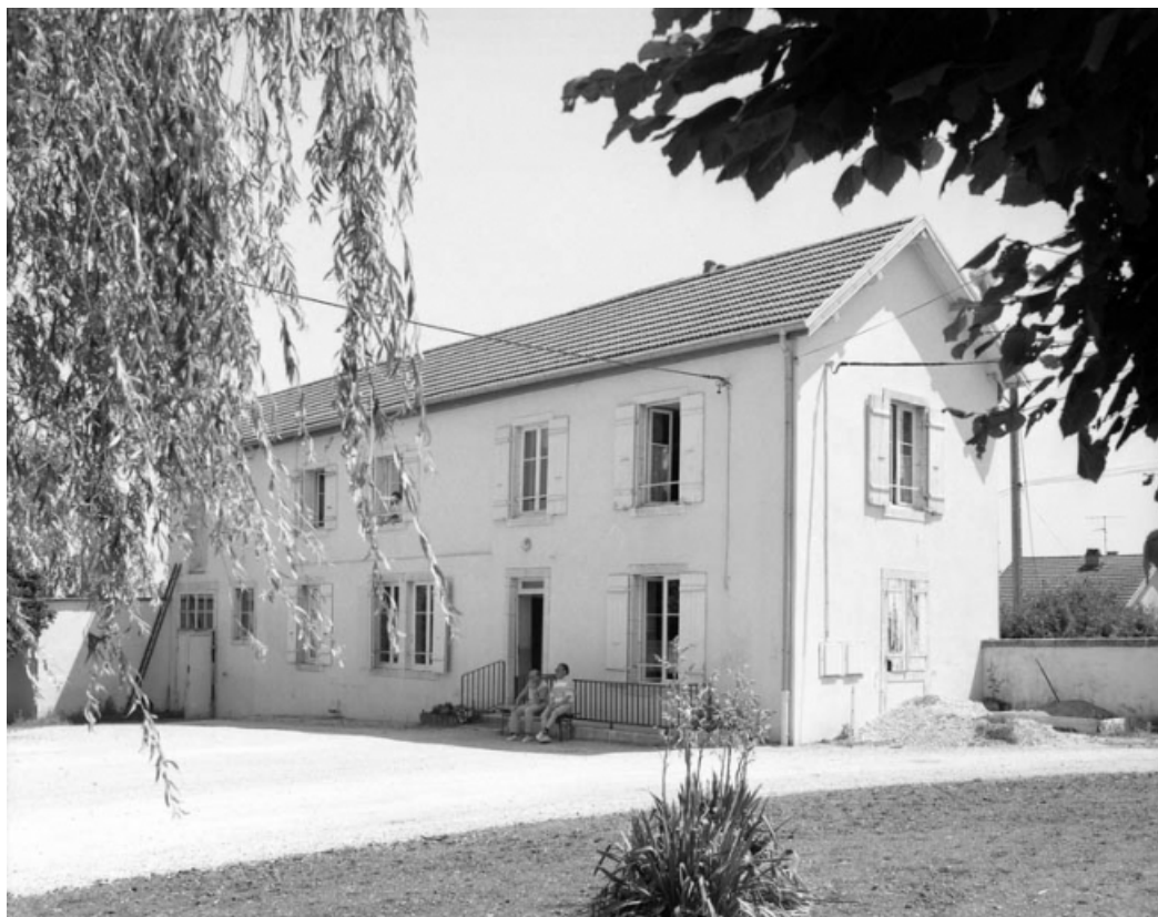
Logement du gardien : de trois quarts droit.
