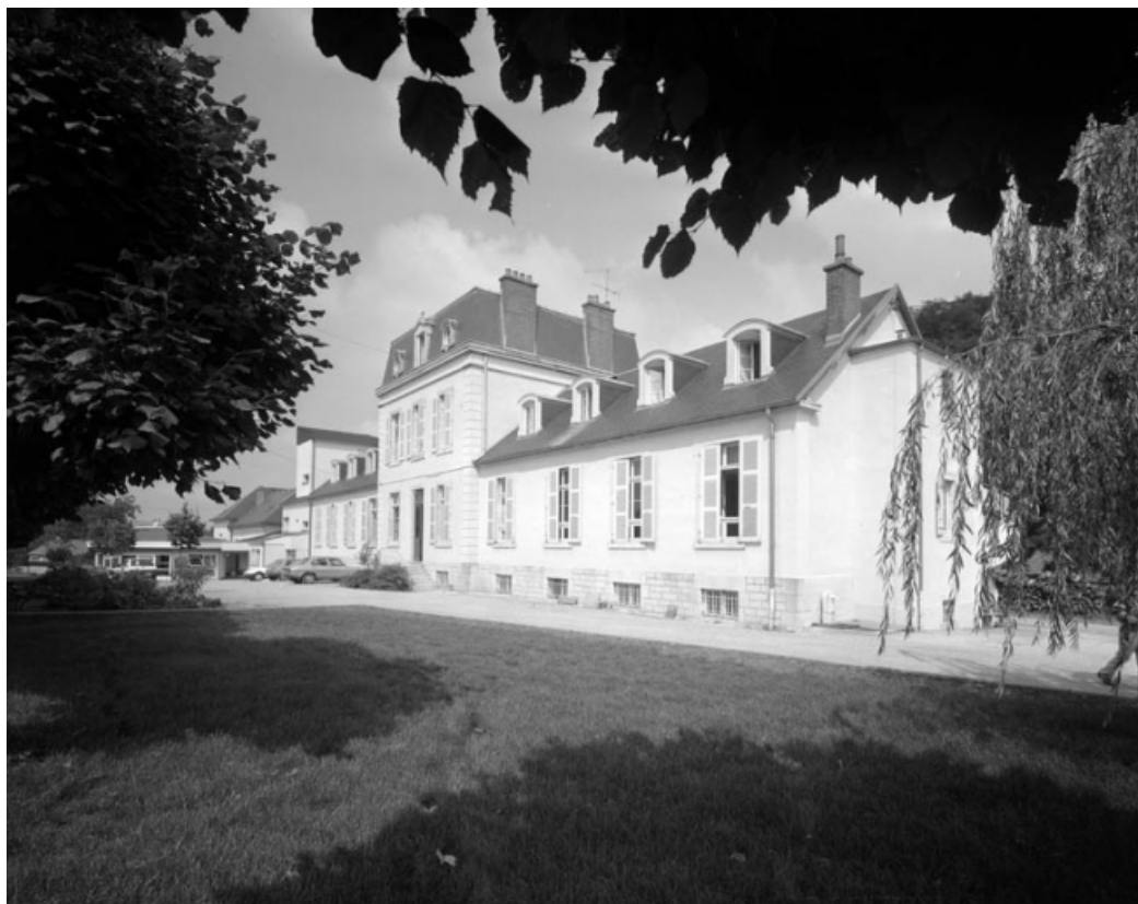
Façade antérieure : vue d'ensemble, de trois quarts droit.
