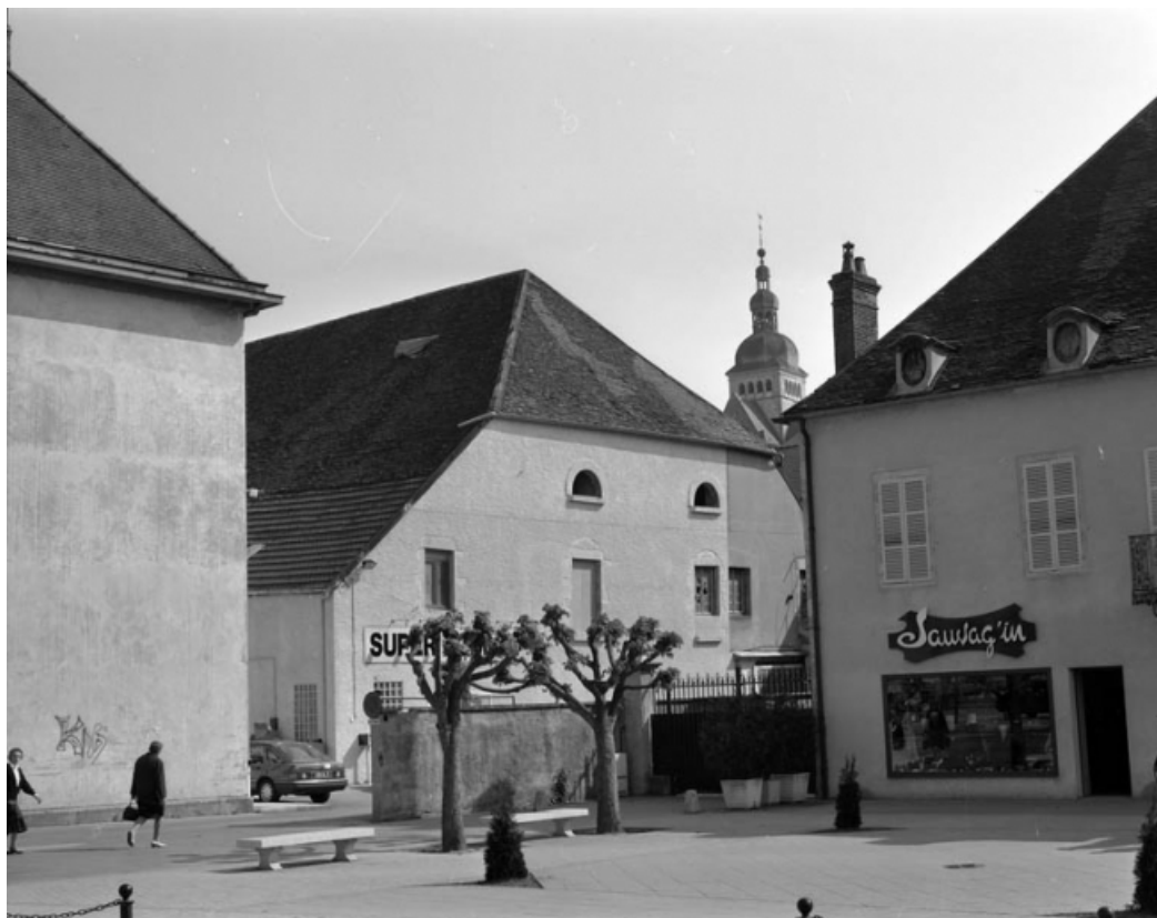
Vue des parties commerciales à gauche de la maison.
