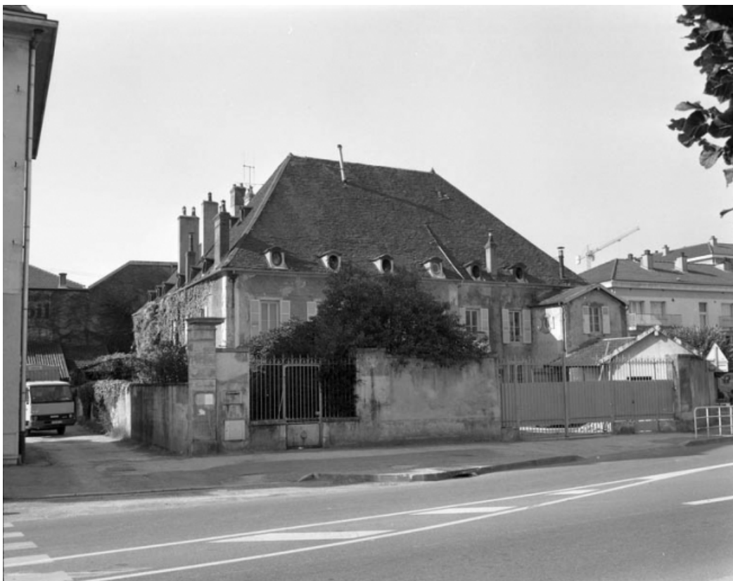
Vue d'ensemble de la maison depuis la rue, avant restauration.
