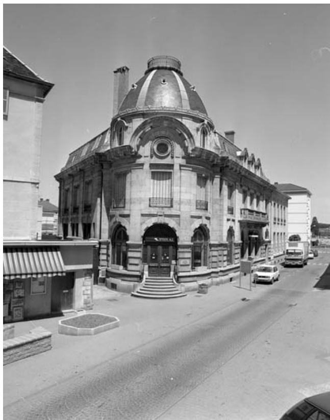
Vue d'ensemble éloignée.
