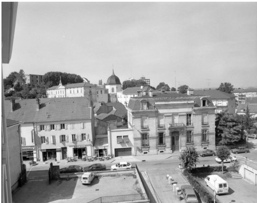
Vue d'ensemble éloignée.
