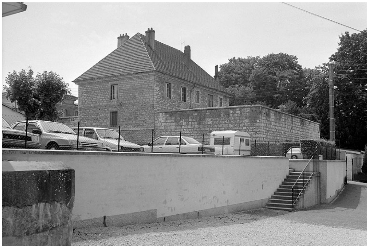
Façades postérieure et latérale droite. 70, Gray rue Signard
