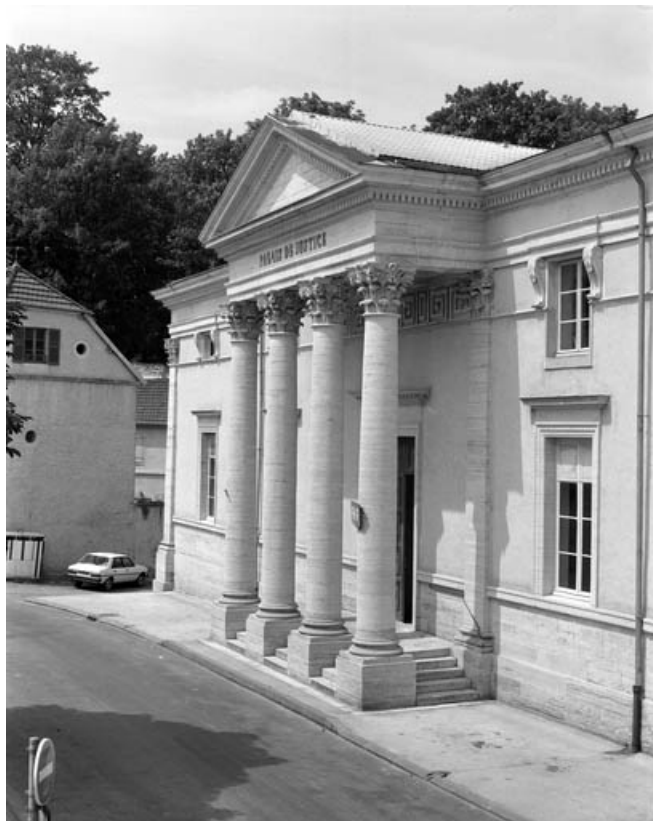
Façade antérieure : avant-corps central de trois quarts droit. 70, Gray rue Signard
