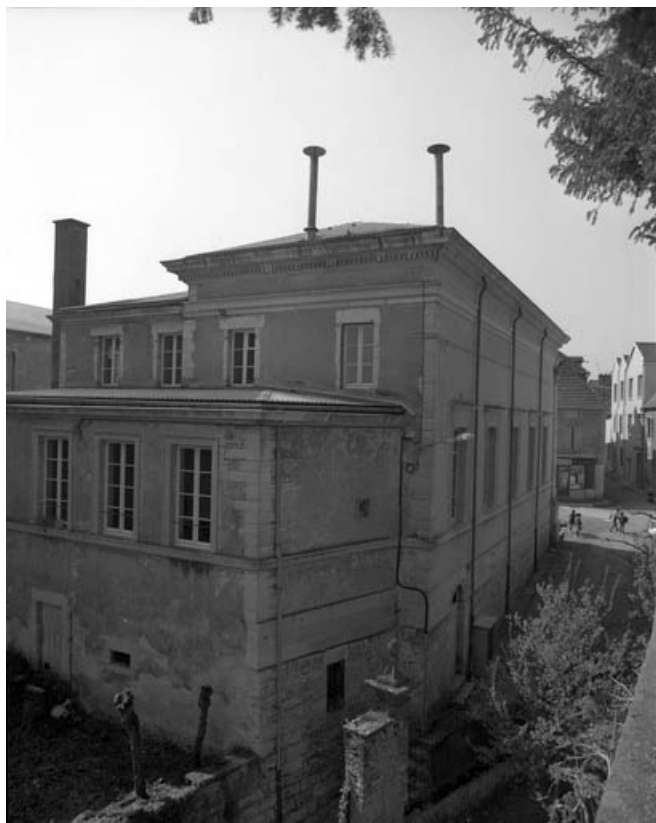
Façade postérieure. 70, Gray rue Signard
