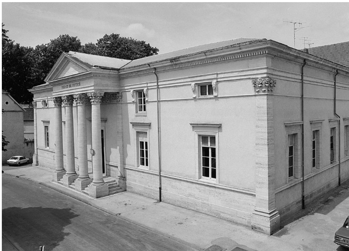
Vue d'ensemble de trois quarts droit. 70, Gray rue Signard
