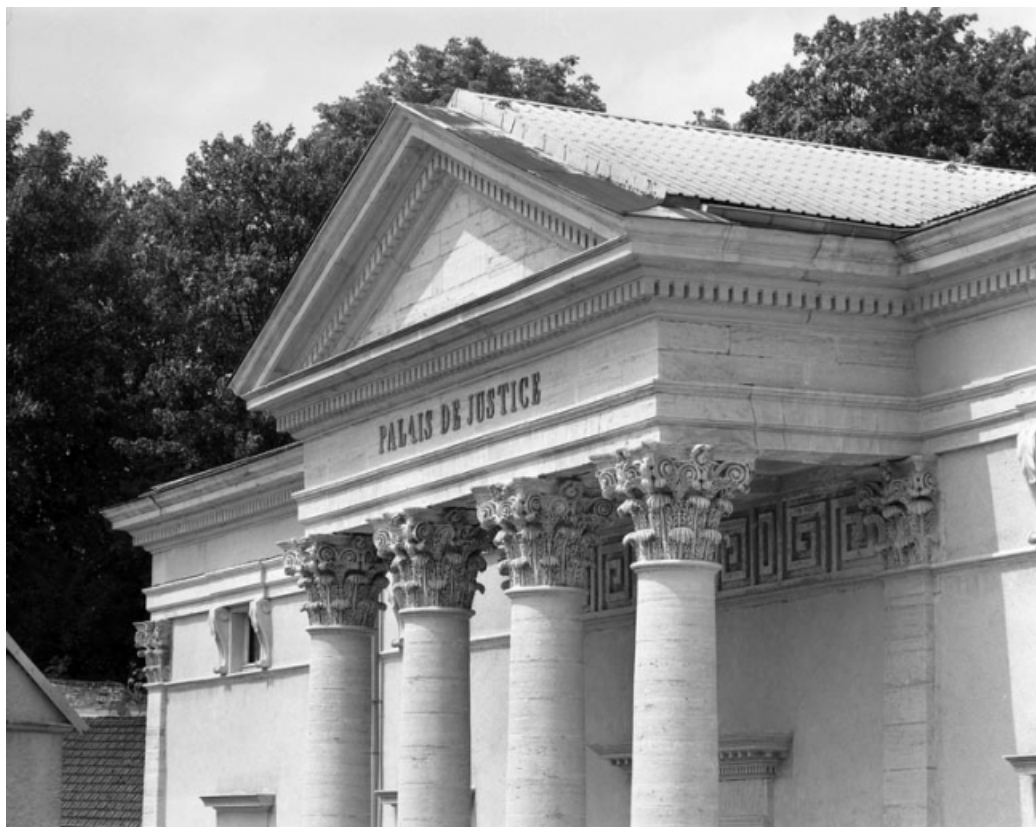
Façade antérieure : avant-corps central, détail du fronton. 70, Gray rue Signard
