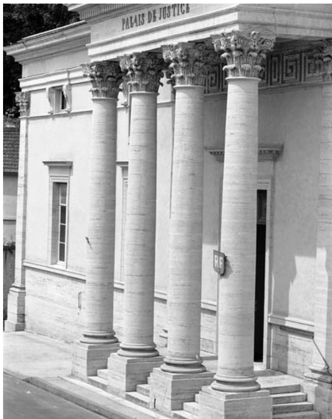
Façade antérieure : avant-corps central, détail des colonnes corinthiennes. 70, Gray rue Signard
