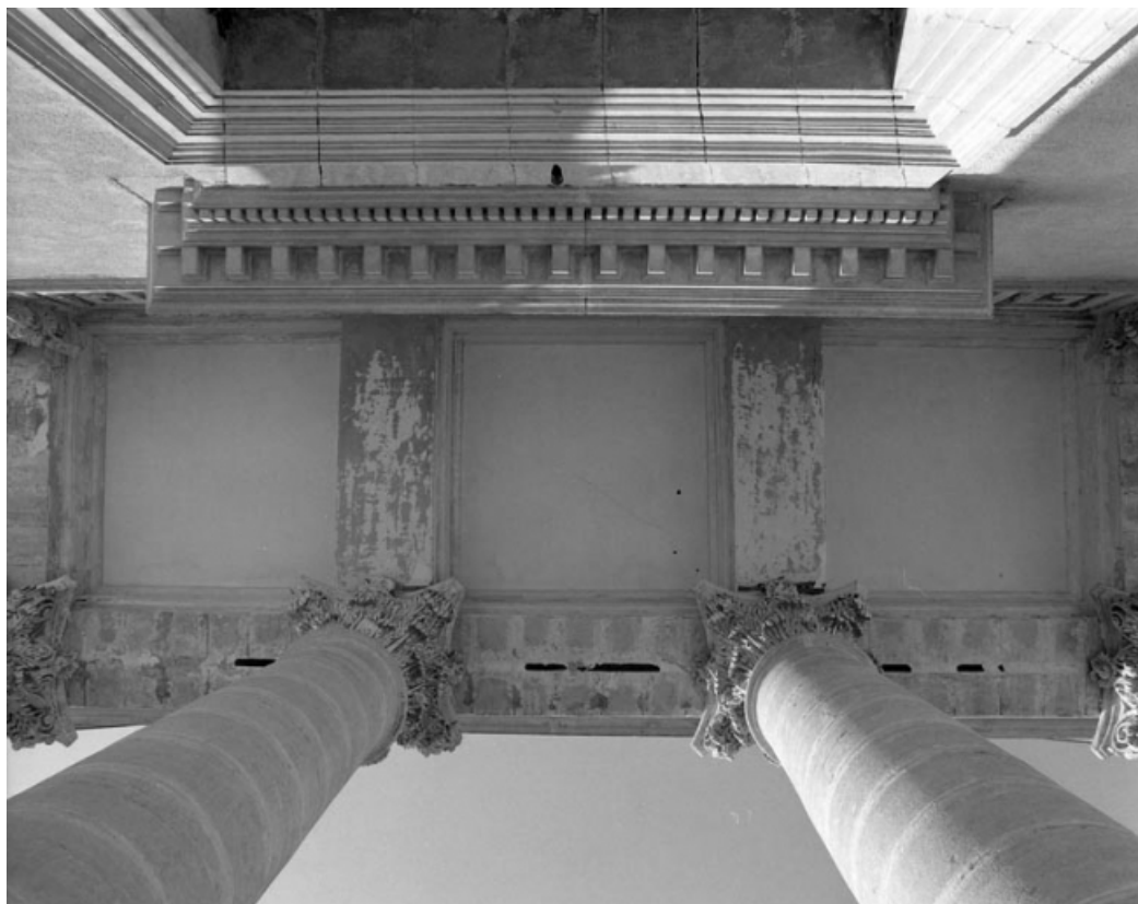
Façade antérieure : plafond de l'avant-corps central.
