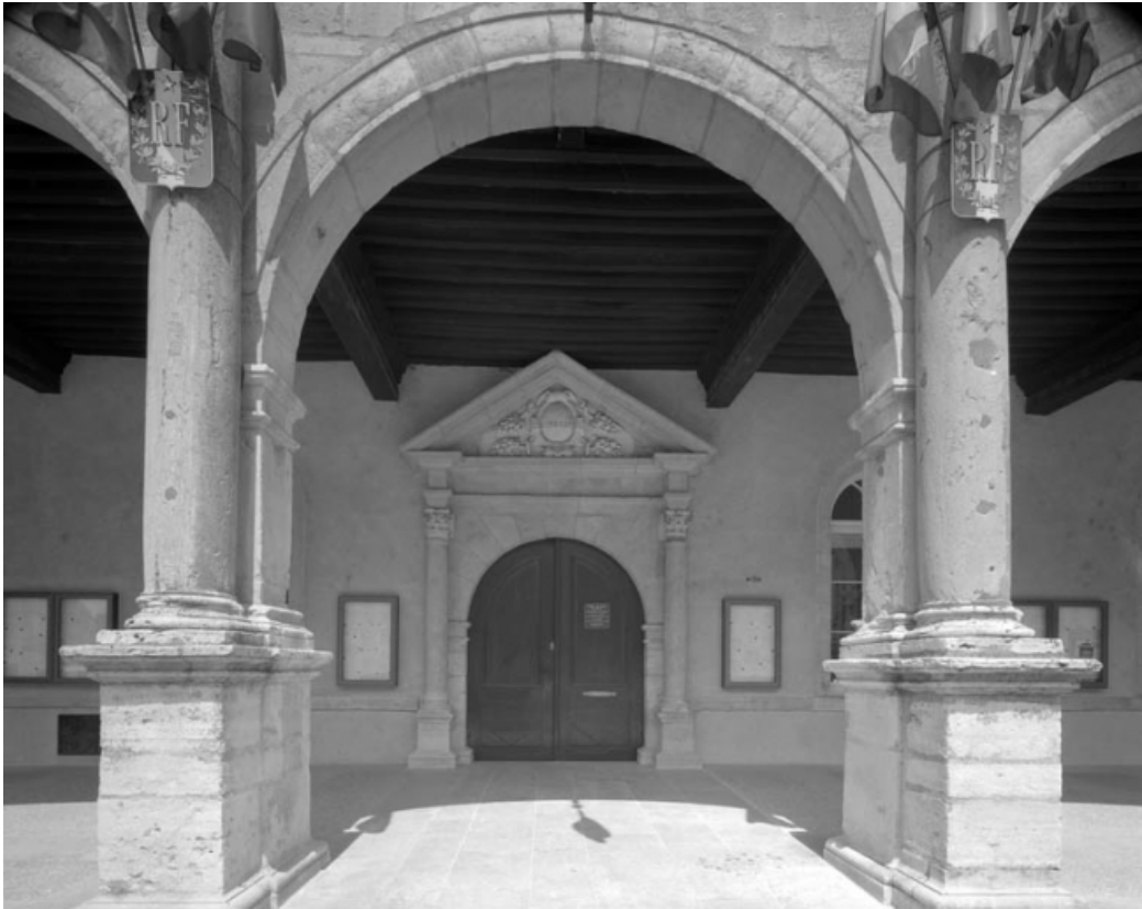
Détail de la porte d'entrée de l'hotel de ville depuis l'extérieur du portique. 70, Gray place De Gaulle
