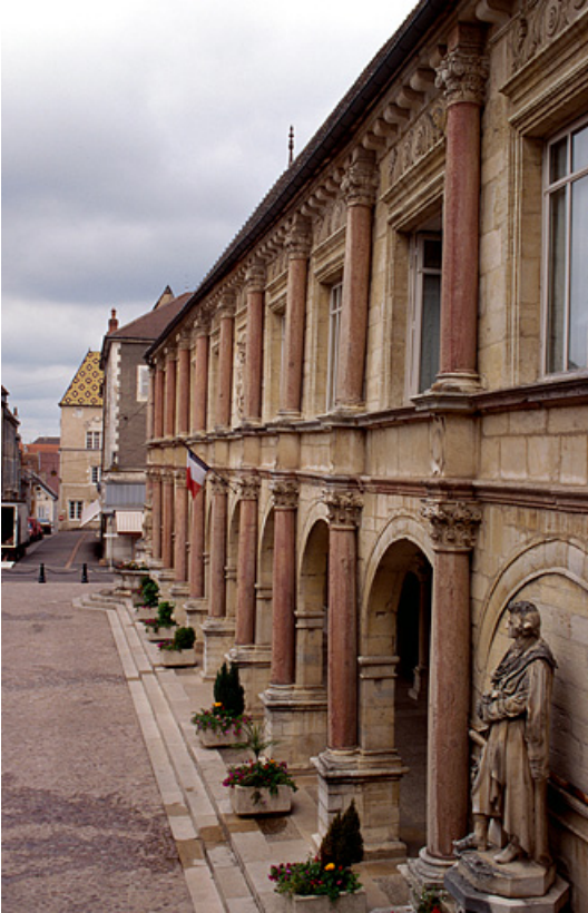
Façade antérieure, de trois quarts droite. 70, Gray place De Gaulle
