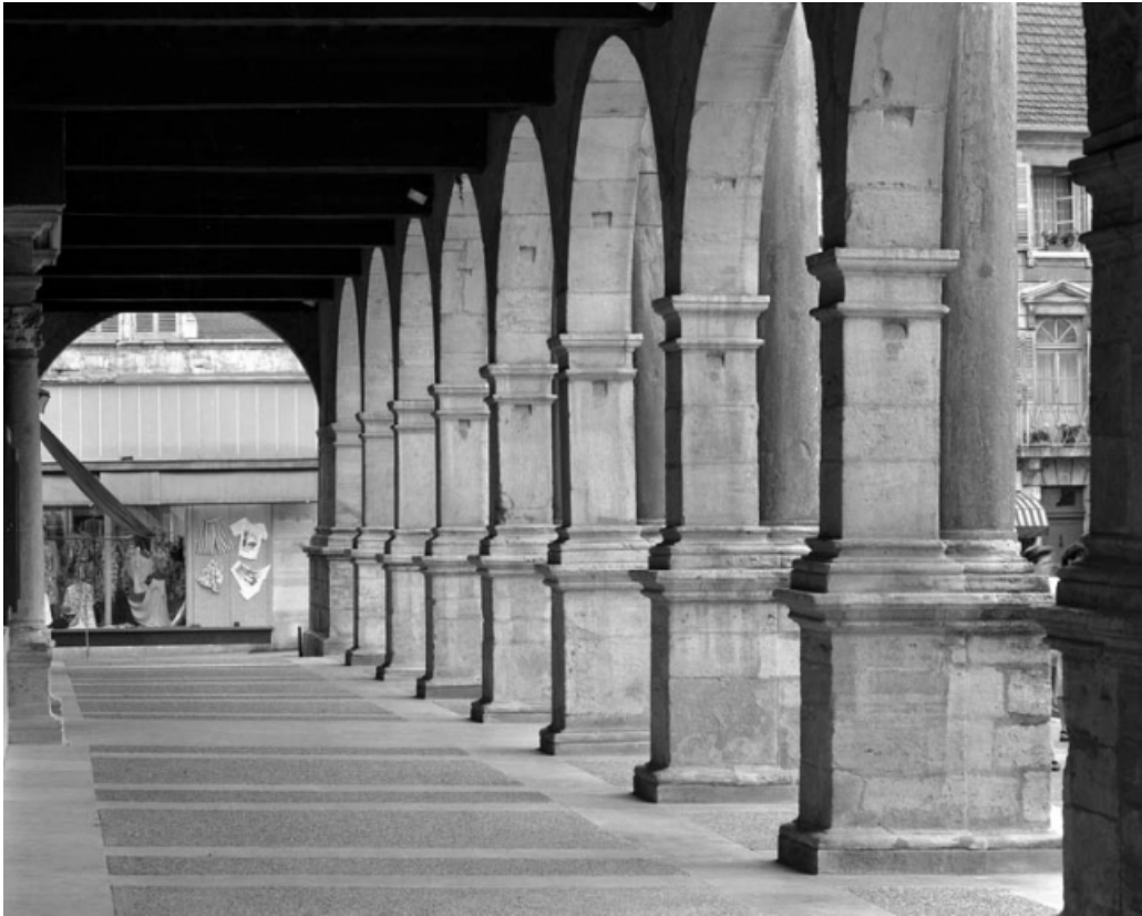
Vue du portique depuis son extrémité droite.
