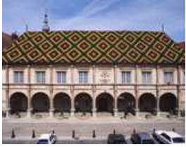
Détail de la façade de l'hôtel de ville : partie centrale. 70, Gray place De Gaulle
