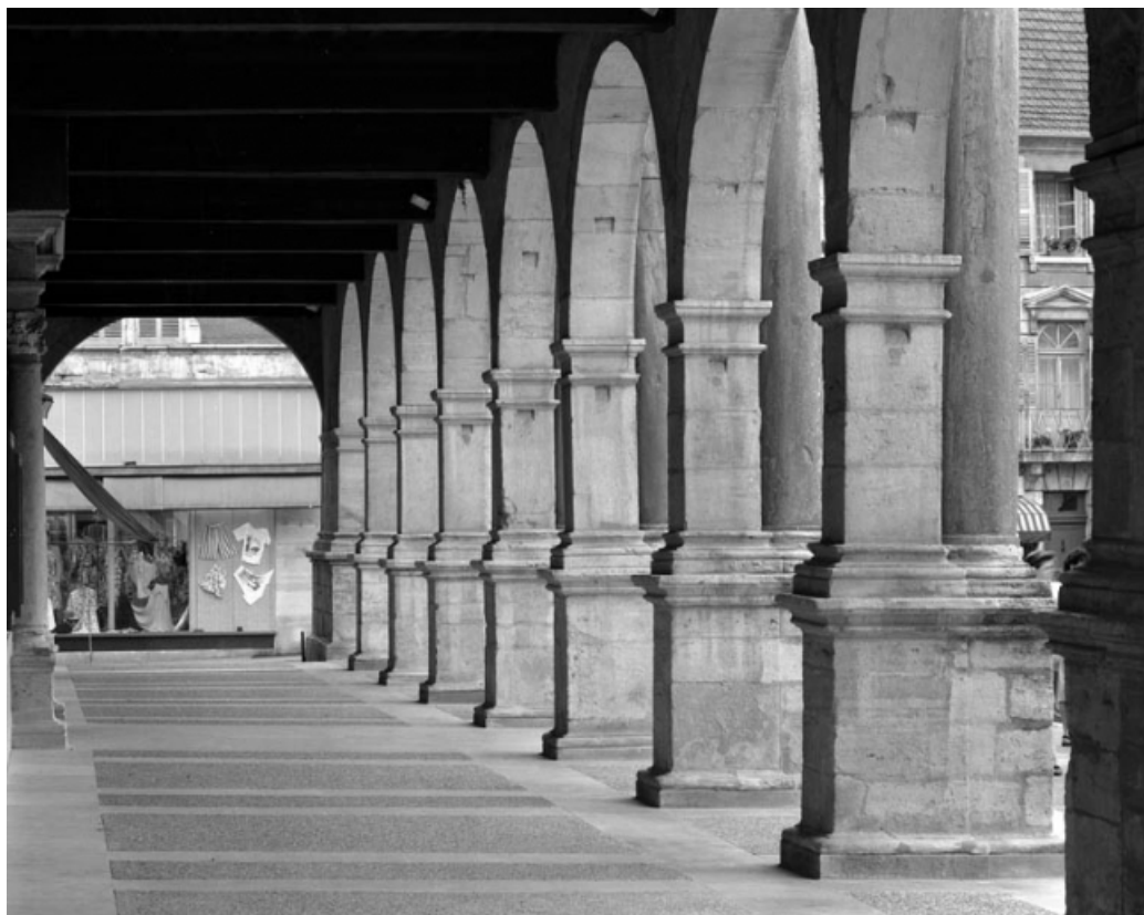
Vue du portique depuis son extrémité droite.
